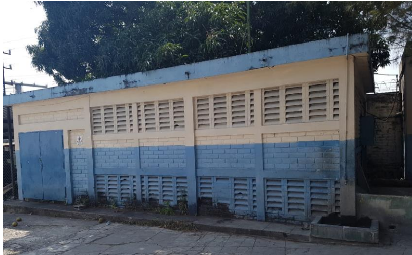
Ilustración 32 Fachada de la entrada a la subestación
