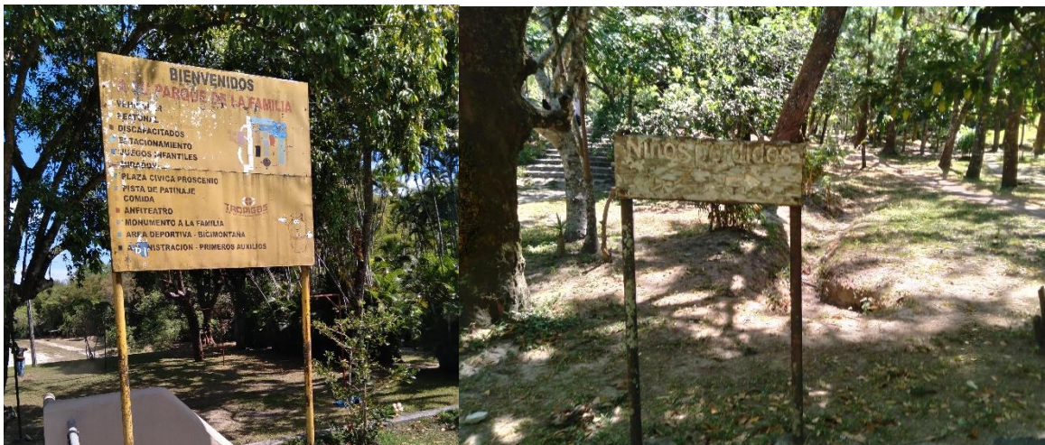
Figura 35 Deterioro de rótulos informativos
