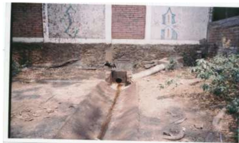
Canaleta de desagüe
