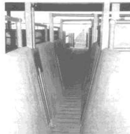
(B) PASILLO DE LADOS INCLINADOS PARA EL GANADO
