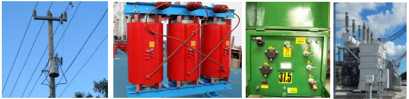
Figura 4- 5. Diferentes tipos de transformadores: a) transformador monofásico, b) transformador seco, c) transformador Pad Mounted, d) transformador de potencia.
