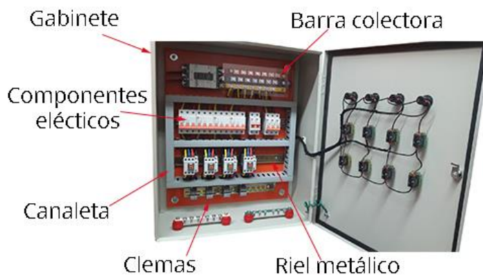
Figura 2- 34. Partes de un tablero eléctrico, norma IEC.
