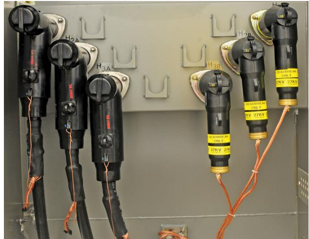
Figura 4- 15. Elementos de conexión para transformadores tipo Pad Mounted en anillo.
