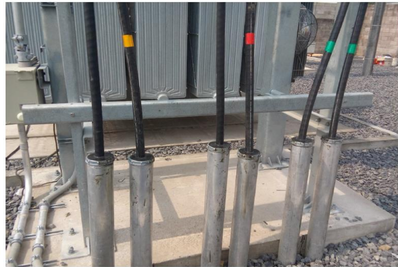
Figura 2- 22. Conductores para distribución subterránea.
