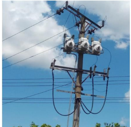
Figura 2- 21. Transformadores de corriente y potencial instalados en poste para medición primaria en media tensión.
