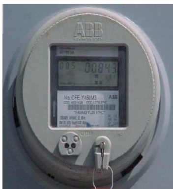
Figura 2- 13. Medidor digital VL28, clase 20 A.
