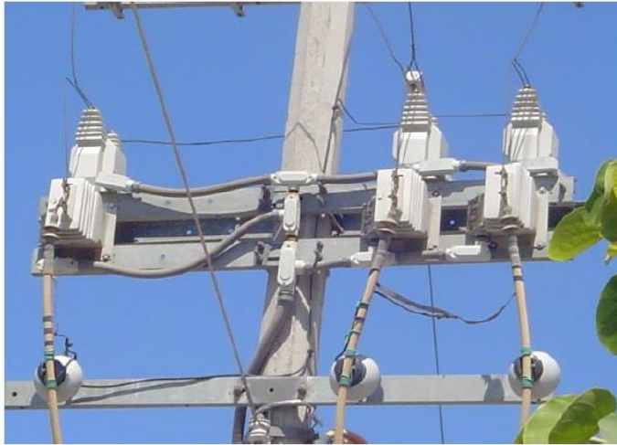
Figura 2- 21. Transformadores de corriente y potencial instalados en poste para medición primaria en media tensión.
