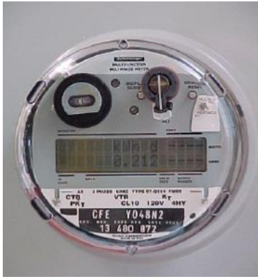
Figura 2- 14. Medidor digital BD2R, clase 10 A.
