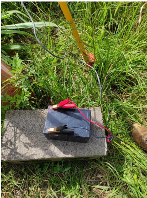
Figura 3.52: Colocado de batería externa al equipo. Fuente: (Ramírez 2021).
