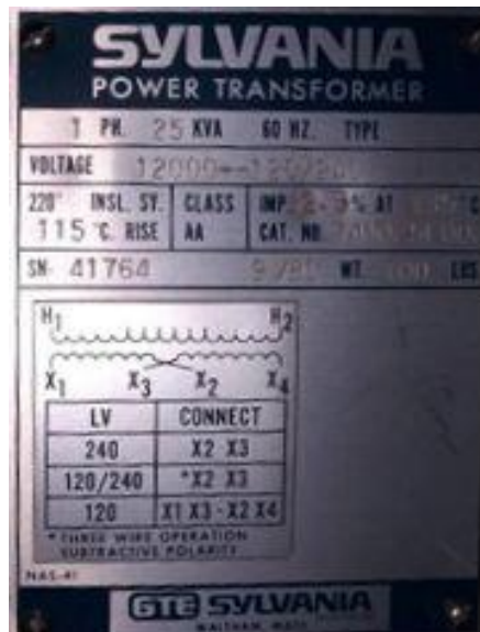
Figura 4.3: Placa de características transformador de aterrizamiento a tierra.
