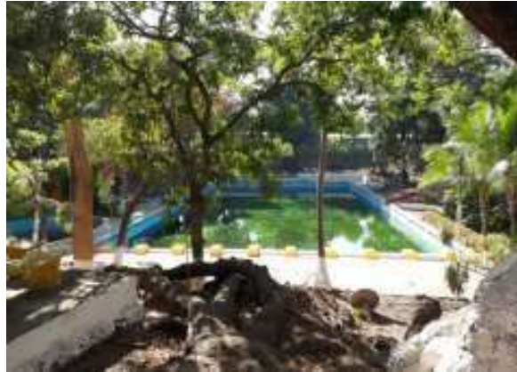
Imagen 4 - Nombre: Estado actual de la Piscina
