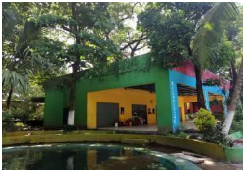
Imagen 43 Infraestructura actual de cafetines.
