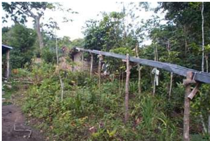
FIG. 3.5 TRANSPORTE DE AGUA LLUVIA COLECTADA HACIA UN TANQUE DE ALMACENAMIENTO
