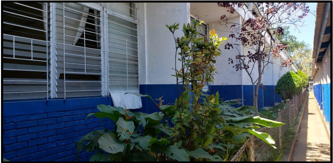
Figura IV-49 “Vista lateral del Edificio C del C.E. INSA”
