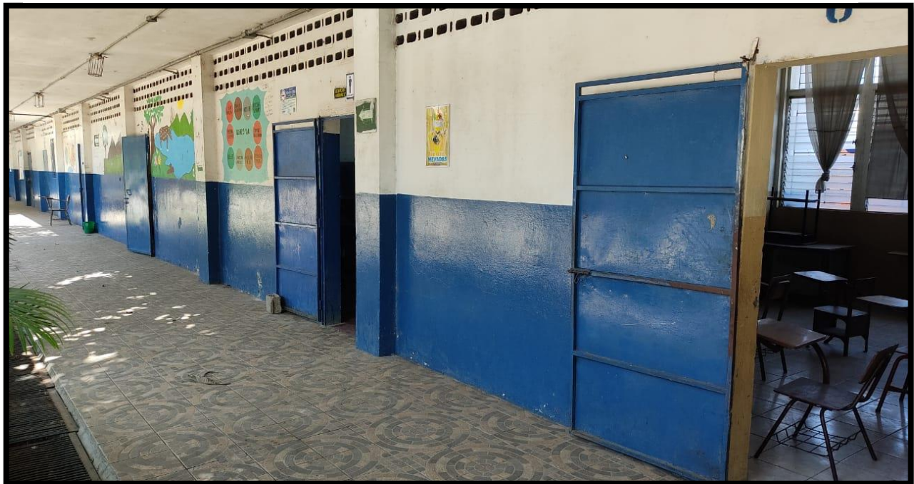
Figura IV-50 “Pasillo interior del Edificio C del C.E. INSA”
