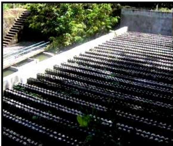
Figura 5.60 Equipo con Operación y Mantenimiento Deficientes. (a) y (b) Acumulación de Desechos en Rejillas. (c) Falta de Mantenimiento en Sedimentador. (d) Patios de Secado de Lodos con Vegetación. (e) y (f) Filtros Biológicos con Vegetación.
