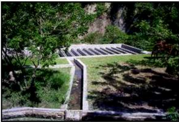
Figura 4.2 Urbanización Vista al Lago una vez Rehabilitada. (a) y (b) Sedimentador Libre de Vegetación, (c) Filtro Percolador Libre de Vegetación.
