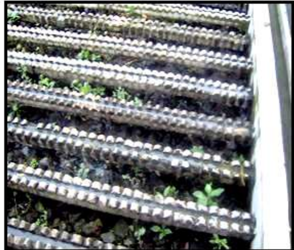
Figura 5.60 Equipo con Operación y Mantenimiento Deficientes. (a) y (b) Acumulación de Desechos en Rejillas. (c) Falta de Mantenimiento en Sedimentador. (d) Patios de Secado de Lodos con Vegetación. (e) y (f) Filtros Biológicos con Vegetación.
