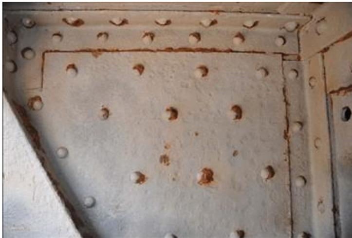
**Figura 2.2 Corrosión localizada en la superficie del metal.**
