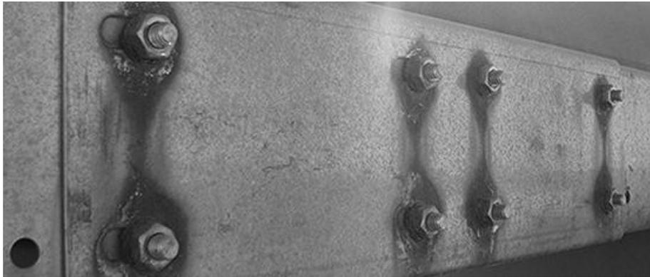
**Figura 2.4 Corrosión galvánica en una placa de acero inoxidable.**
