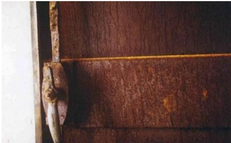
**Figura 2.1 Corrosión general en una puerta de metal.**
