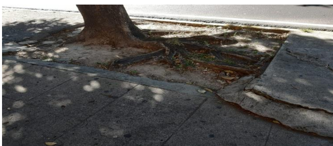
Figura 1. Daño de acera por raíces Swietenia humilis en la calle Rubén Darío.
