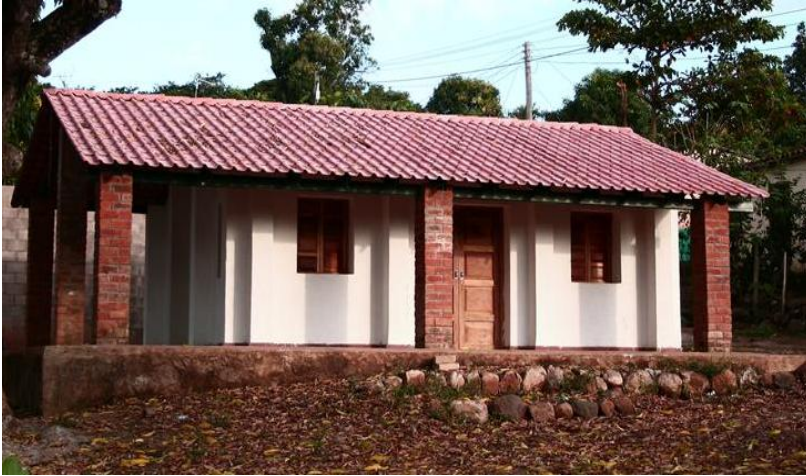
Imagen 3.7: Sistema de construcción Adobe Sismo-Resistente
