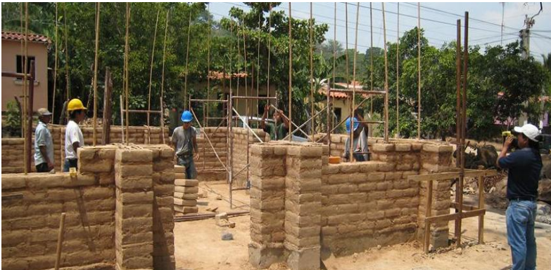
Imagen 3.8: Construcción de casa con sistema de Adobe
