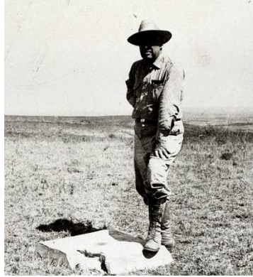
Figura 5. Meades Ranch Triangulation Station, fundamental station for the North American Datum of 1927. Fuente: Curso de especialización en tecnología GPS y sensores remotos para proyectos de Ingeniería Civil. Ingeniero Wilfredo Amaya.
