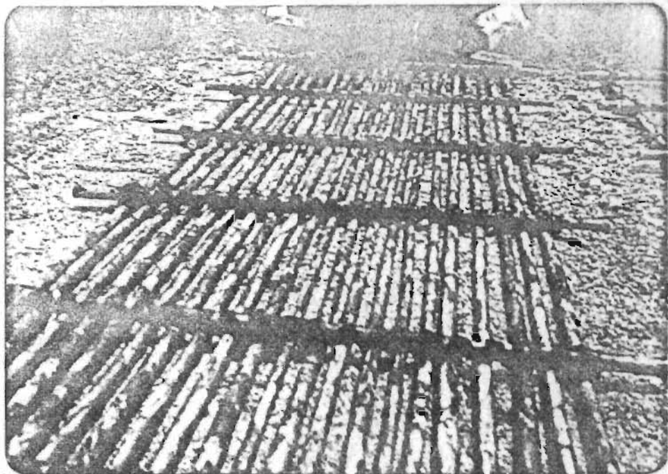
Armado de Panel Vara de castilla amarrado con corteza de árbol de capulín
