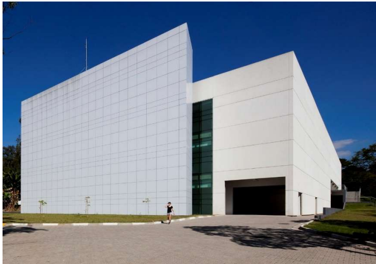
Imagen 82: Vista exterior del laboratorio.
