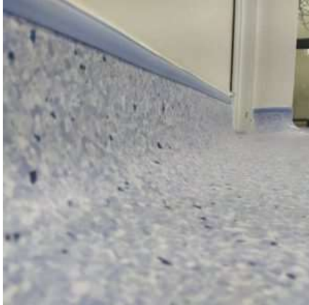
Imagen 147: Ejemplo de piso y curva sanitaria.
