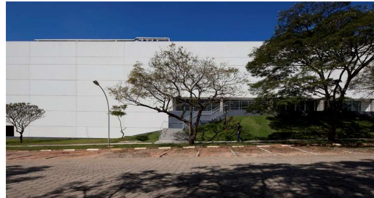
Imagen 87: Vista exterior del laboratorio.
