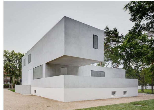
Imagen 109: Reconstrucción de las casas para los maestros de la Bauhaus. Fuente: https://tecne.com/arquitectura/bauhaus-acuerdo-minimalista/
