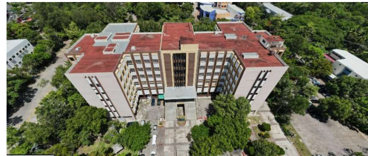
Imagen 39: Vista aérea del edificio de Medicina.
