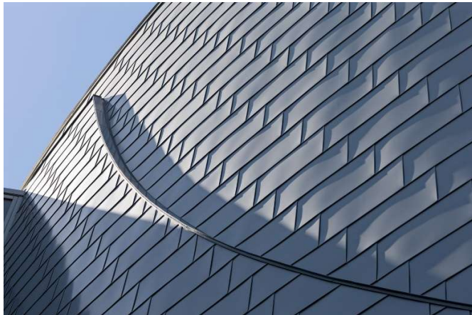
Imagen 73: Revestimiento de aluminio en fachada del laboratorio.
