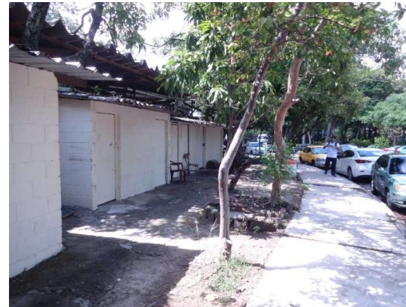
Imagen 34: Talleres de mantenimiento al poniente del edificio de Medicina.
