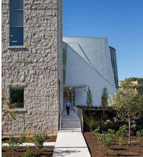
Imagen 72: Acceso peatonal del laboratorio.
