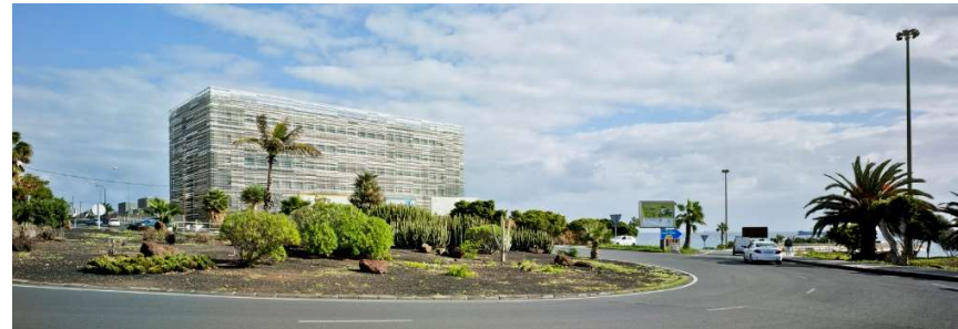
Imagen 74: Vista exterior del laboratorio.
