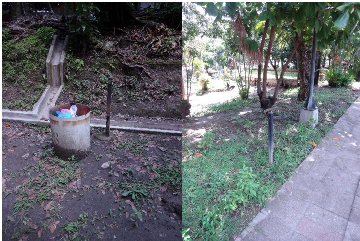
Imagen 35: Basureros en mal estado o no existen.
