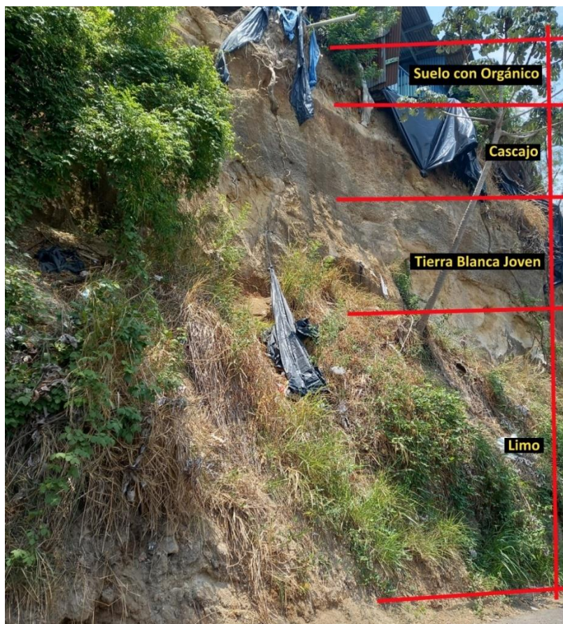
Figura 4.3. Estratos que conforman el talud (agosto, 2021).
