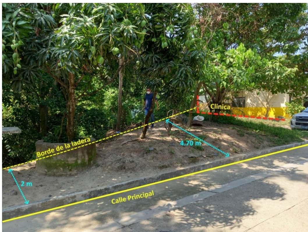
Fotografía 3.3. Esquina de la clínica hasta donde se ha extendido la erosión en ladera (mayo, 2021).
