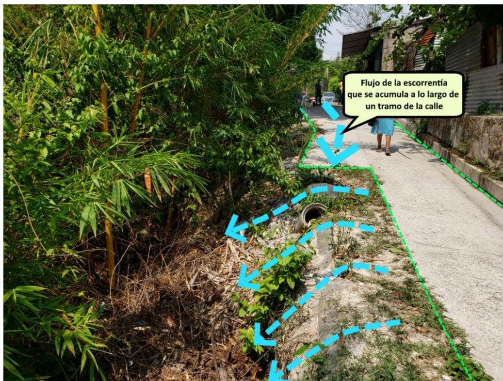
Fotografía 3.5. Flujo de la escorrentía en la calle (mayo, 2021).
