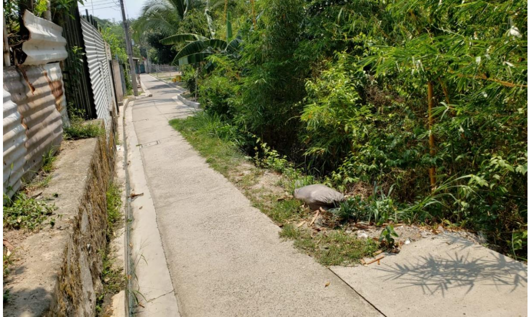
Fotografía 3.1. Tramo inconcluso de la calle principal (abril, 2021).
