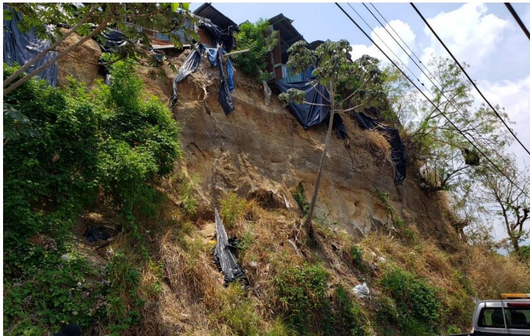
Fotografía 4.3. Fotografía del talud tomada en el 2021 (abril, 2021).
