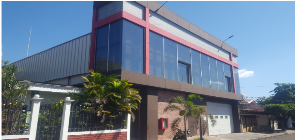
Ilustración 1: Fachada de Panadería Sinaí
