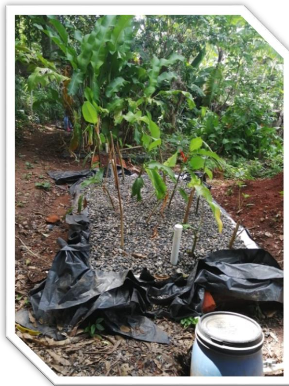
Anexo A4. Humedal artificial para tratamiento de aguas grises en Guacotecti
