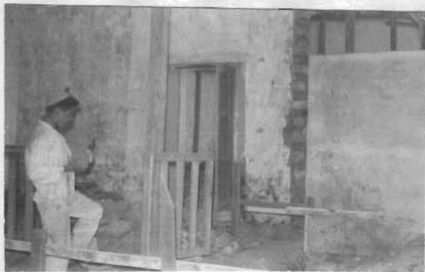
Vista interior de la Unidad de Salud en reparación
