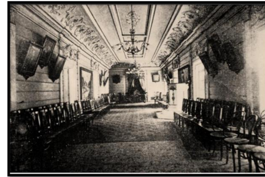
Ilustración 22: Interior de Paraninfo, del antiguo edificio de la Universidad de El Salvador
