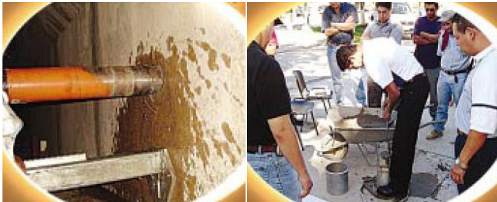
Fig. 4.11 Inyección y prueba de revenimiento del relleno fluido.
