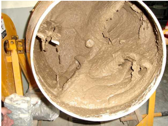
Fig. 4.2 Mezclando Suelo Cemento
