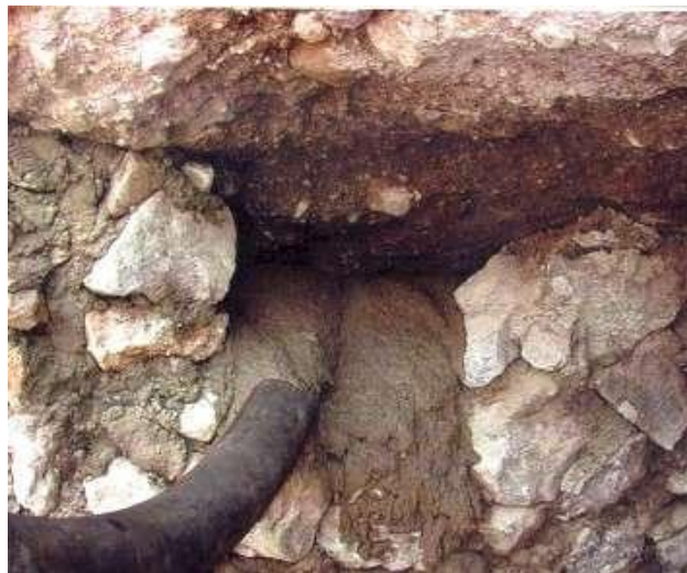
Fig. 4.10 Colocación de Relleno Fluido
