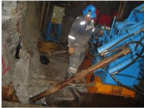
Fig. 4.3 Inyección de Suelo Cemento
