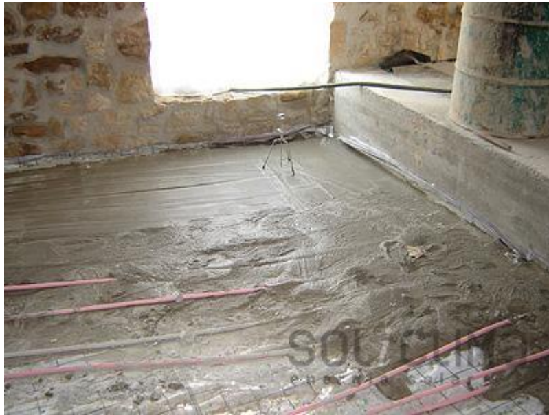
Fig. 4.1 Suelo Cemento Aplicado como Base Para Asentamientos
