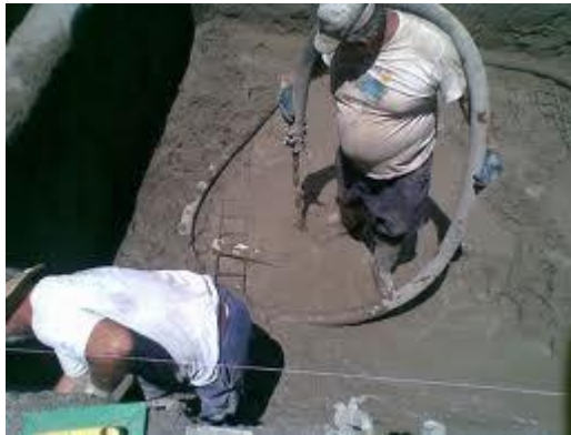
Fig. 4.6 Colado de Mezcla de Suelo Cemento
