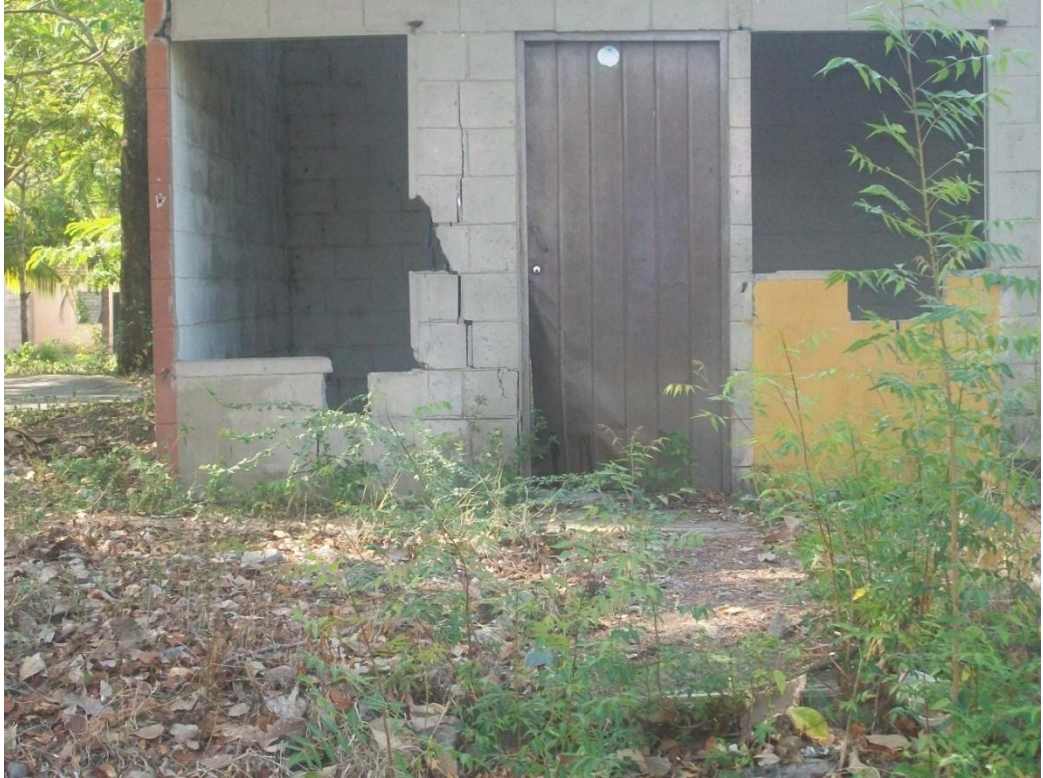
Fig. 2.5 Efectos de asentamientos en viviendas de interés Social
