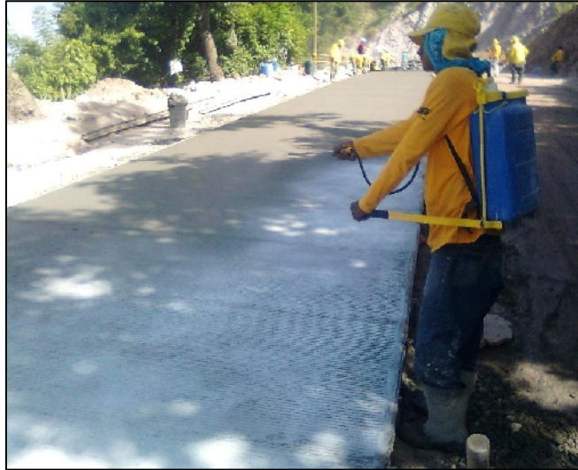
Figura 4.5 Curado del concreto con aditivo formador de membrana.
