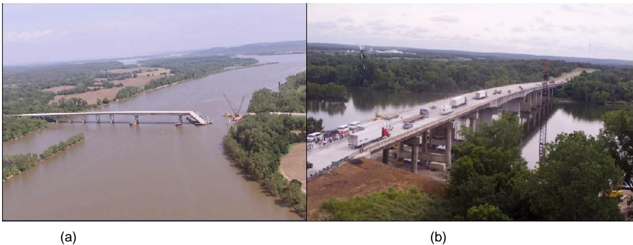
Figura 2.16: Puente Interstate-40. Webber Fall.
