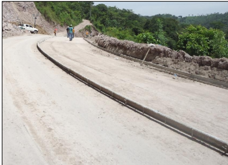
Figura 4.1 Molde metálico anclado en la base.
