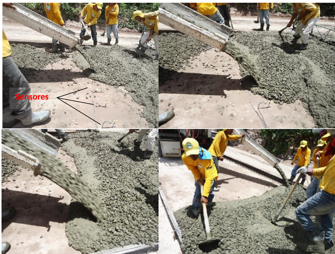
Figura 4.10 Resumen fotográfico de pavimentación con sensores de madurez colocados en la base.
