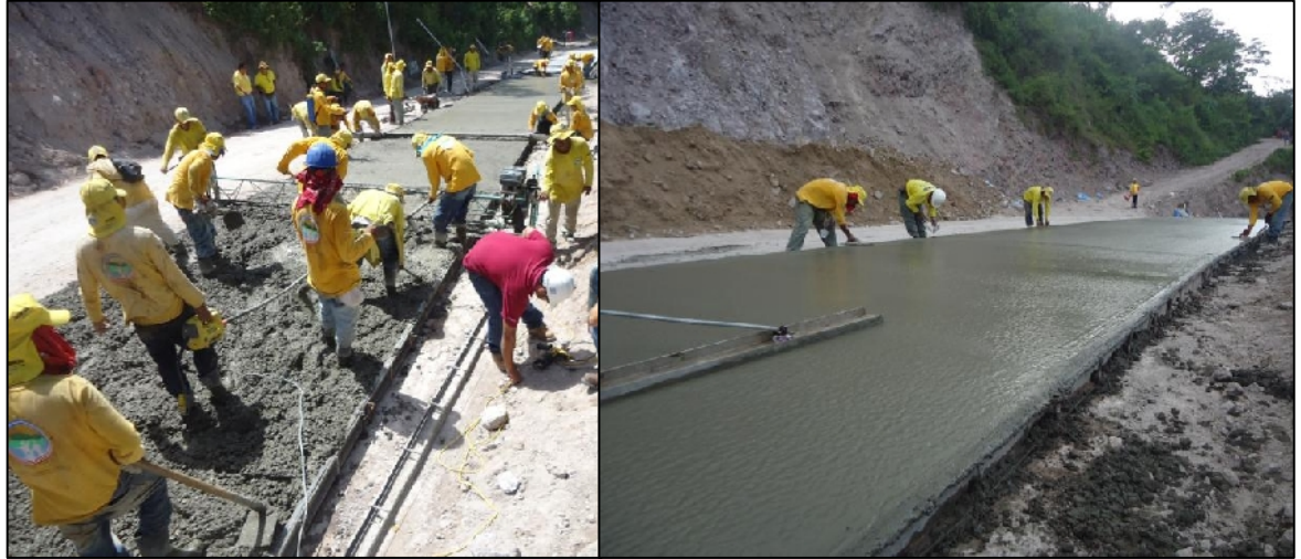
Figura 4.3 Enrazado y acabado de superficie de concreto.
