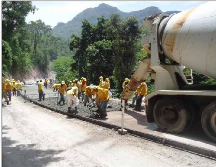
Figura 4.2 Descarga y distribución del concreto en zona de colado.
