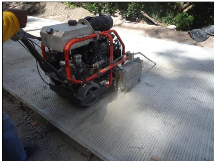
Figura 4.6 Corte de junta transversal
