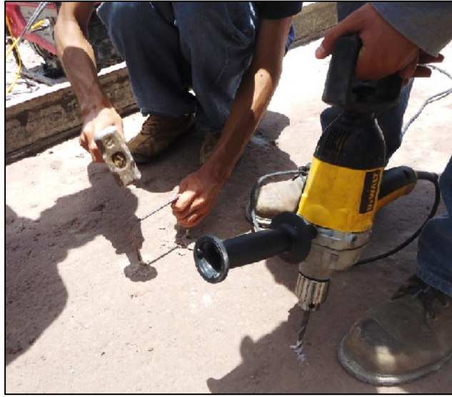
Figura 4.7 Instalación de grapas para colocación de sensores.
