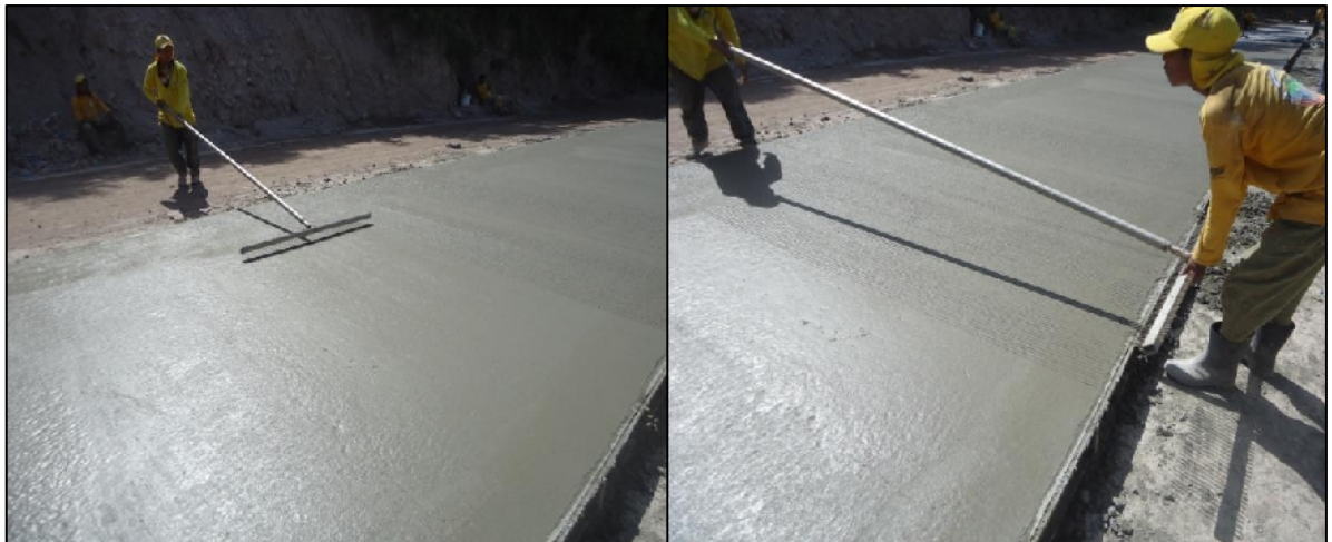
Figura 4.4 Texturizado del concreto con cepillo celdas metálicas.
