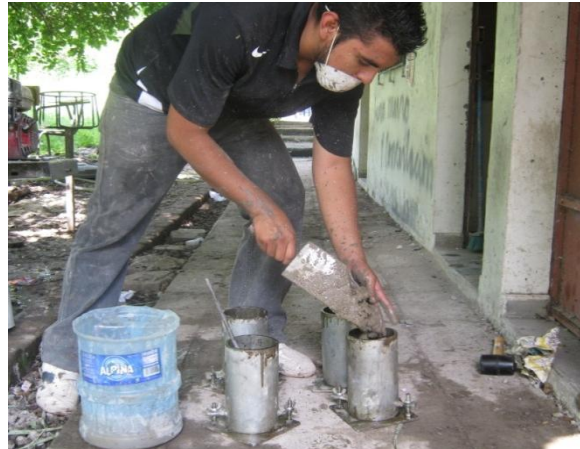
2) COLOCACION DEL CONCRETO EN MOLDES CILINDRICOS DE 8"
