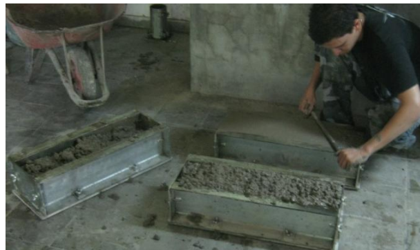
3) COLOCACION DEL CONCRETO EN LOS MOLDES PARA VIGA
