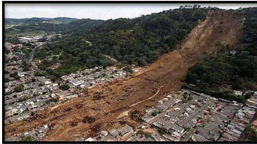
Figura 2.3 Deslizamiento Colonia Las Colinas (2001).
