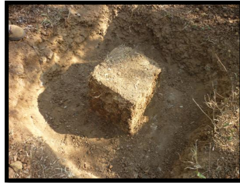
Figura 3.5 Ahondamiento en excavación.
