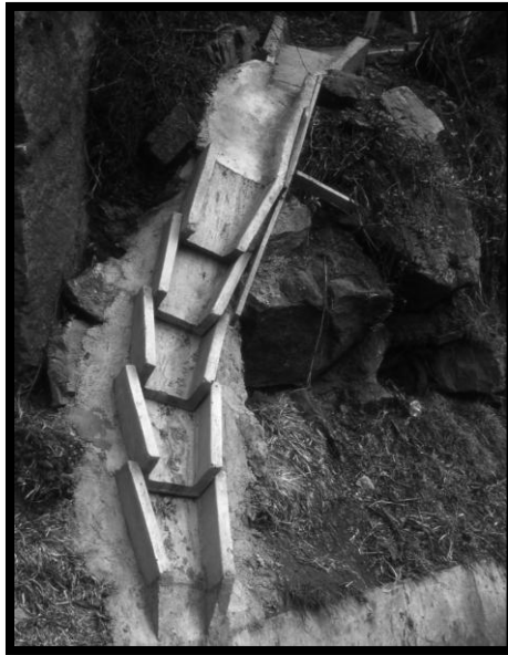
Figura 5.23 Torrentera de elementos prefabricados.
