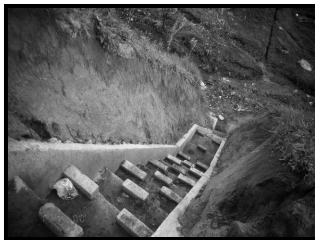
Figura 5.22 Torrentera en gradería con bloques de concreto.
