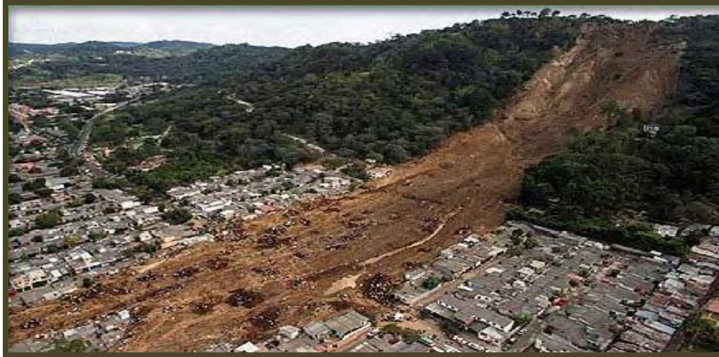
Figura 1.1 Deslizamiento en Colonia Las Colinas (Enero 2001).
