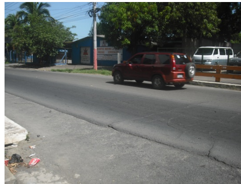
IMAGEN N° 15: daño de carpeta asfáltica en puente Ochoa
