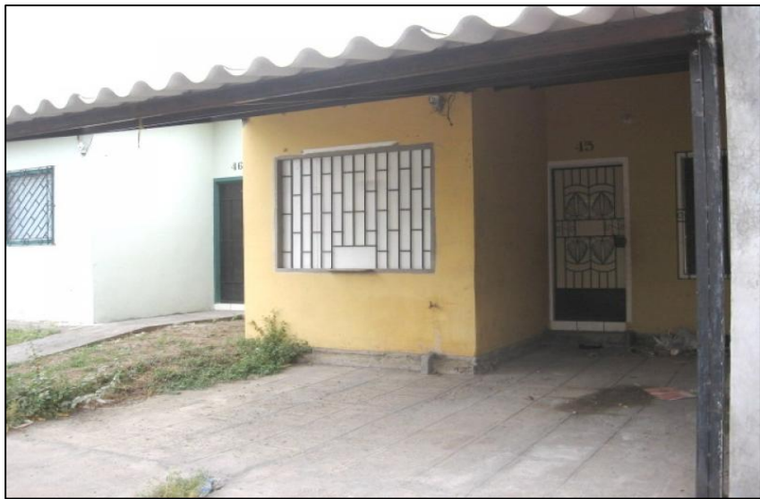
IMAGEN 3: TIPO DE VIVIENDA PROMEDIO EN URBANIZACIONES DE SAN MIGUEL
