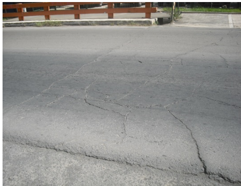
IMAGEN N° 15: daño de carpeta asfáltica en puente Ochoa
