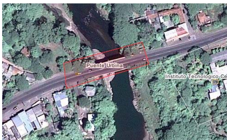
Figura 9, Imagen satelital del puente Urbina
