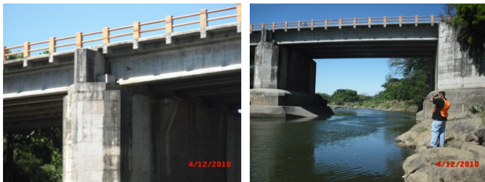
IMAGEN N° 21 del puente Urbina / Inspección echa con uso de binocular
