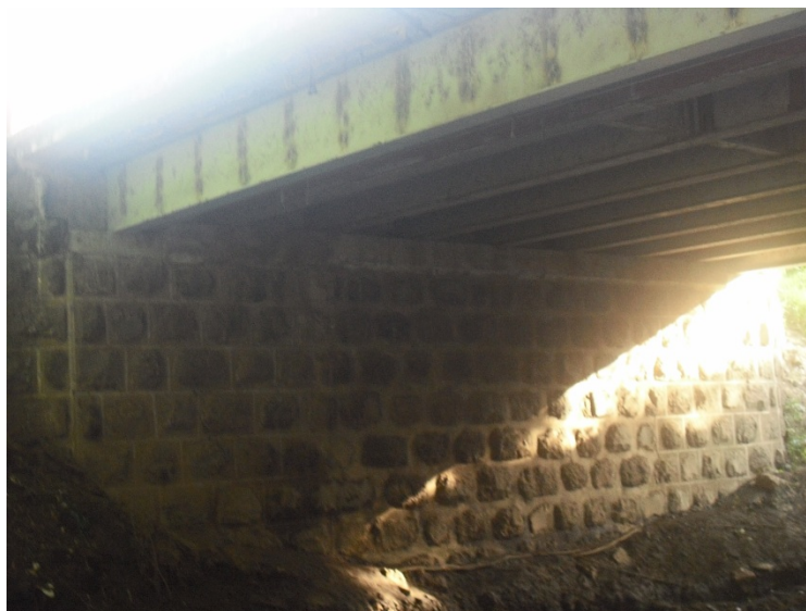
IMAGEN N° 24 de viga y estribo de puente El Jute
