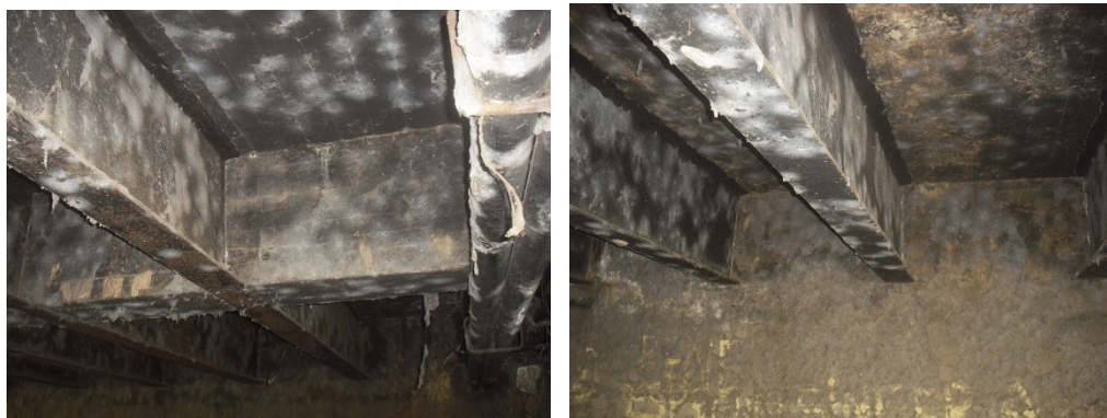
IMAGEN N° 19 Vigas de puente El Triangulo
