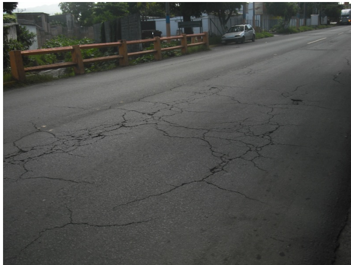
IMAGEN N°18 Superficie de rodadura en puente el triangulo
