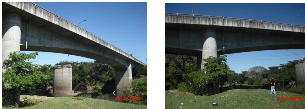
IMAGEN N° 22 de estructura y inspección en puente Luis De Moscoso
