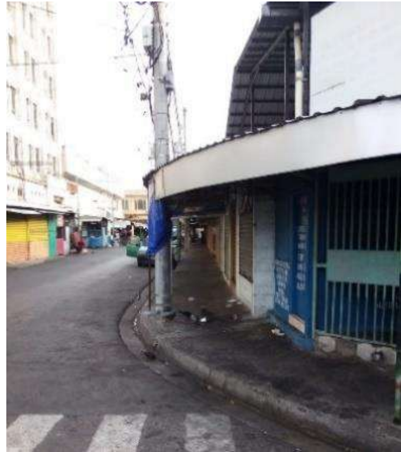
Imagen 69: Esquina suroeste del Terreno Fuente: Visita de Campo
