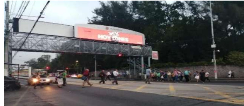
Imagen 71: Alameda Juan Pablo II Fuente: Visita Técnica abril 2021
