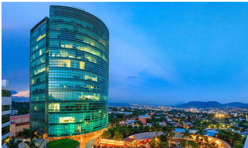
Imagen 09: Edificio Ex banco salvadoreño Fuente: AGRISAL
