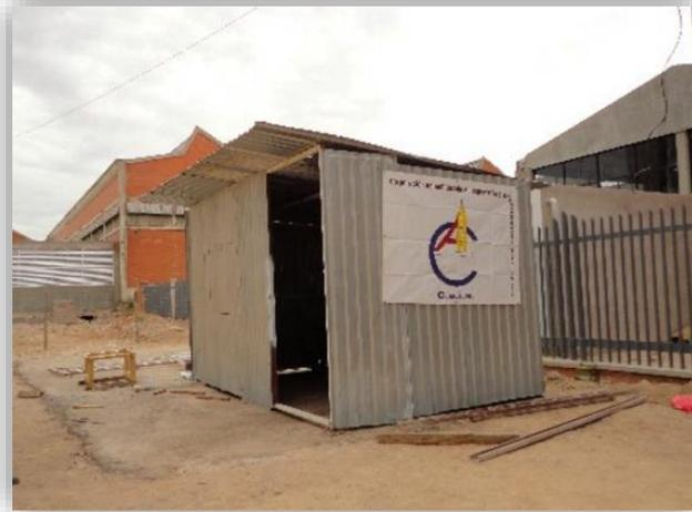
Imagen 3: BODEGA PROVISIONAL DE CHAPA METÁLICA PARA ALMACENAR MATERIALES
