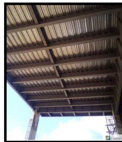
Figura 29. Estructura metálica, fuente: Google Imágenes.
