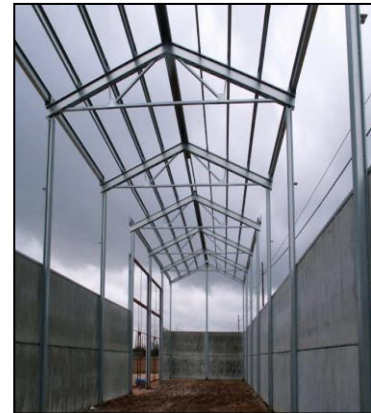
Figura 21 , Estructura de cubierta, fuente: Google imágenes.
