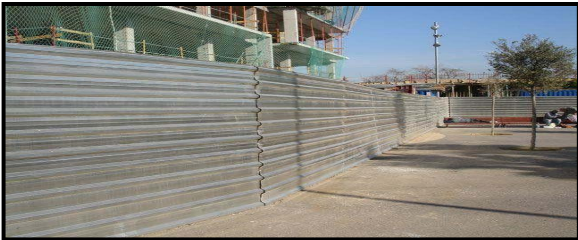
Figura 25. Bodega y oficinas provisionales, fuente: Google
