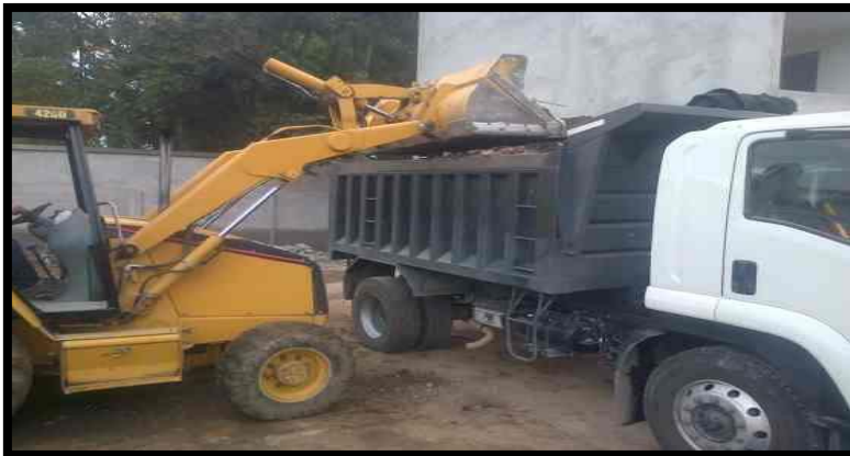
Figura 48. Desalojo de material de excavación, fuente: Google imágenes
