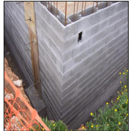
Figura 18 , Muro de mampostería, fuente: Google imágenes.
