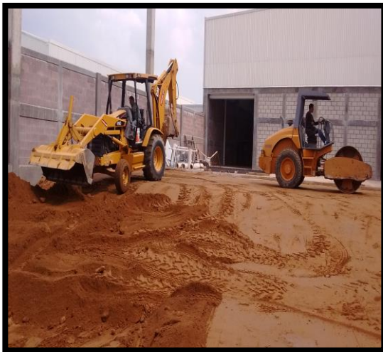
Figura 26. Obras de terracería, fuente: Google Imágenes.
