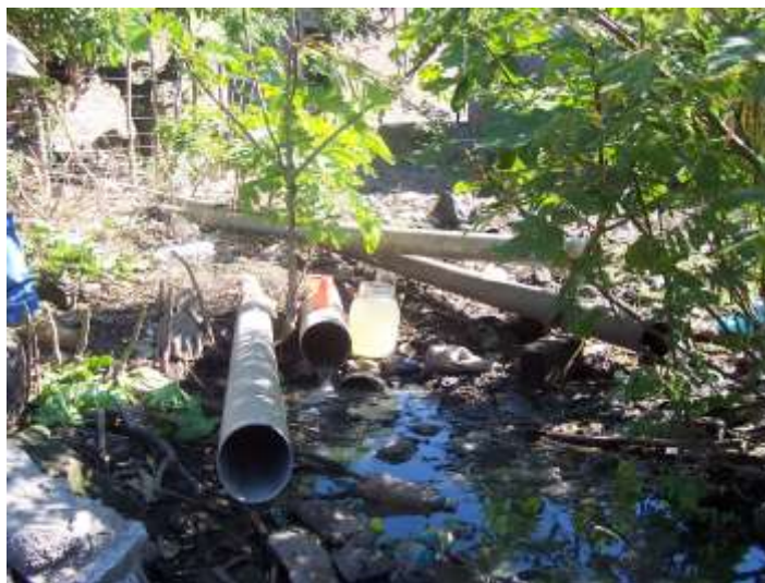
Fig. 5.2 Desemboque de tuberías donde se tomo la muestra de manera directa
