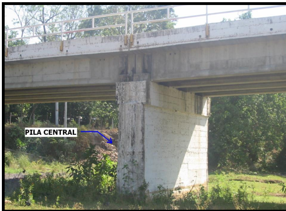
Fotografía 6.8. Vista típica de la pila central de un puente.
