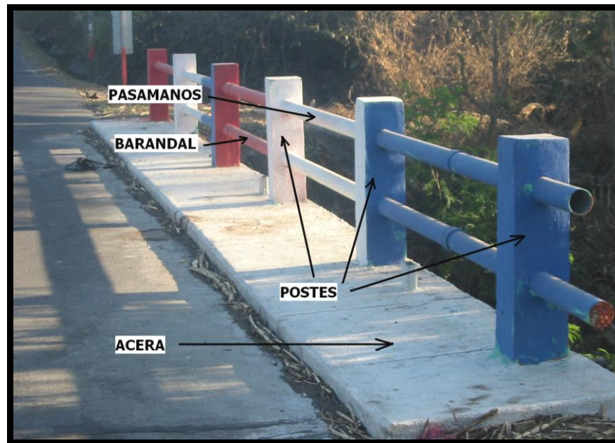
Fotografía 6.4 Imagen del sistema soportante de barandal de un puente.
