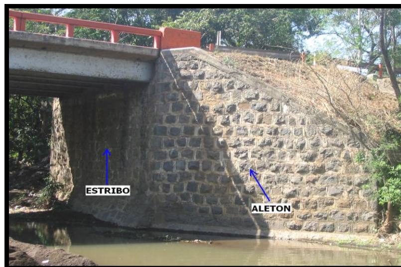
Fotografía 6.6 Vista típica de un estribo de mampostería y aletones de un puente.
