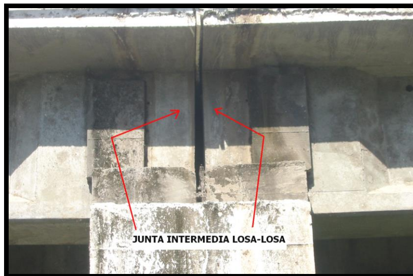
Fotografía 6.5 Imagen de una junta entre losa y losa.
