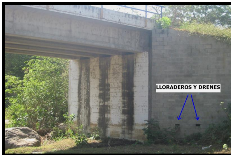
Fotografía 6.7. Vista típica de los drenajes de un puente.
