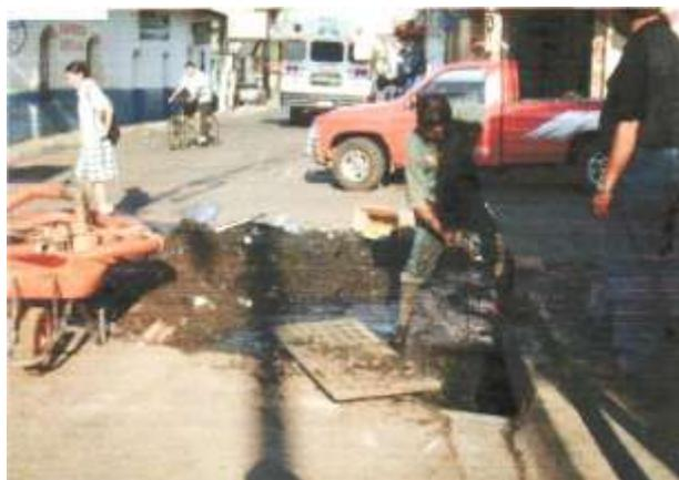
**IMAGEN 2.4 LABORES DE LIMPIEZA REALIZADAS POR EMPLEADOS DE LA ALCALDÍA MUNICIPAL A UN TRAGANTE OBSTRUIDO POR LA ACUMULACION DE BASURA, UBICADO ENTRE LA 1<sup>ERA</sup> C. ORIENTE Y 3<sup>ERA</sup> AV. NORTE**
