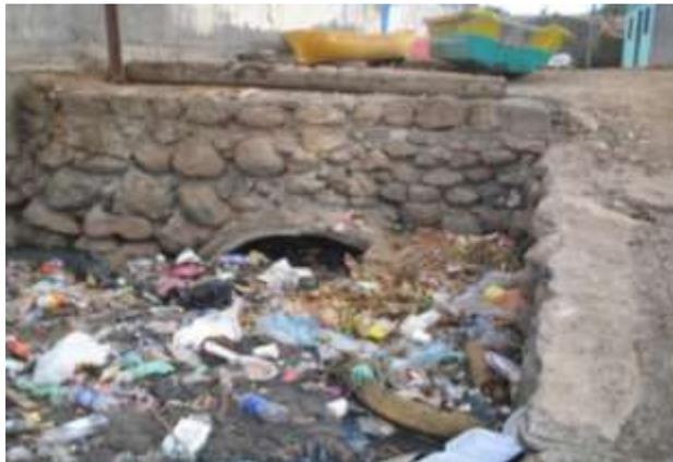
**IMAGEN 2.2 DESCARGA DE AGUAS LLUVIAS Y NEGRAS SOBRE LA BAHÍA,
