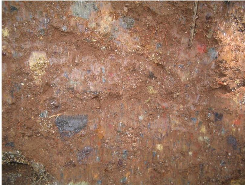
**Fotografía 3.1.** Estado de descomposición química que presenta uno de los taludes en el punto de emplazamiento.
