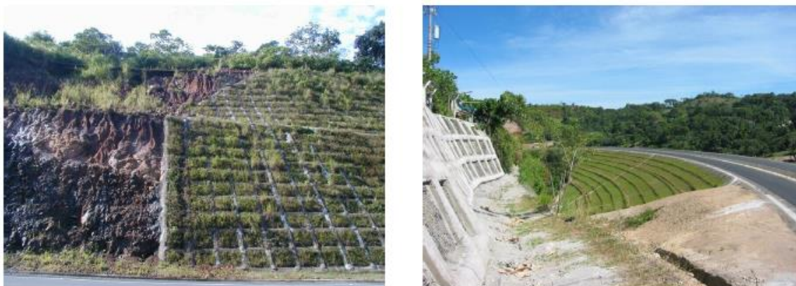
Figura 12: protección de taludes y terracerías. Fuente: Nippon Koei
