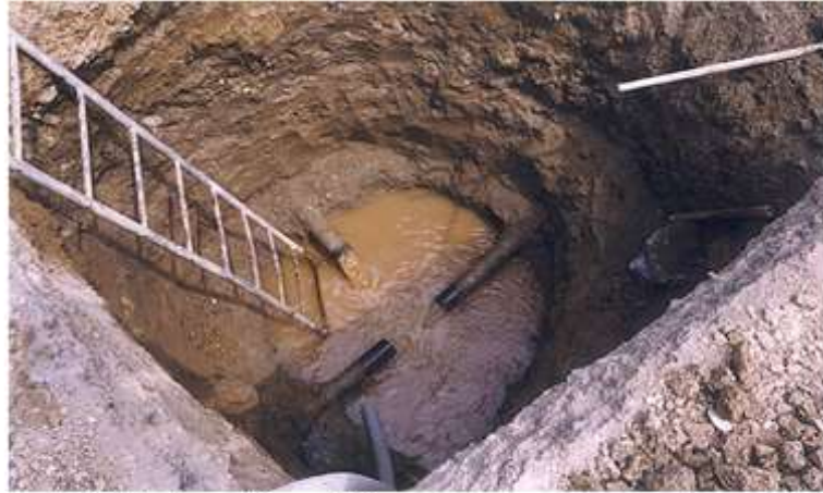
Figura 1.5 Si colapsa el sistema de saneamiento, uno de los mayores riesgos para la salud es la contaminación de las Fuentes de agua
