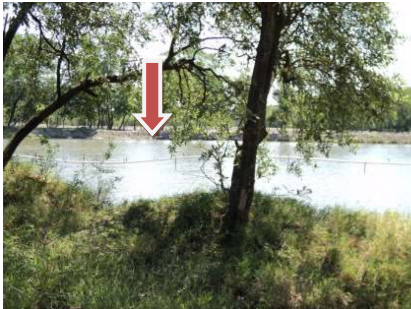
Figura 5.28 En la fotografía se puede observar claramente como el sistema de agua potable atraviesa los estanques camaroneros los cuales resultan dañados con las inundaciones al igual que el sistema de agua potable
