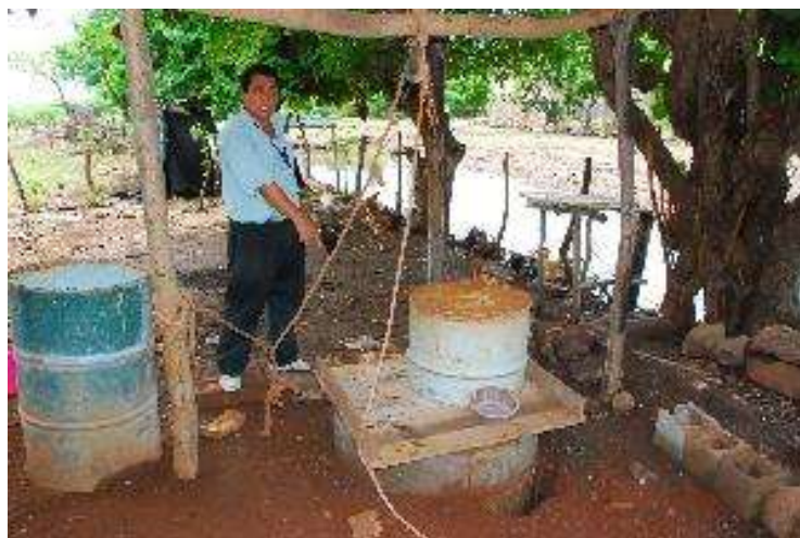
Figura 5.22 Daños en los pozos artesanales de agua
