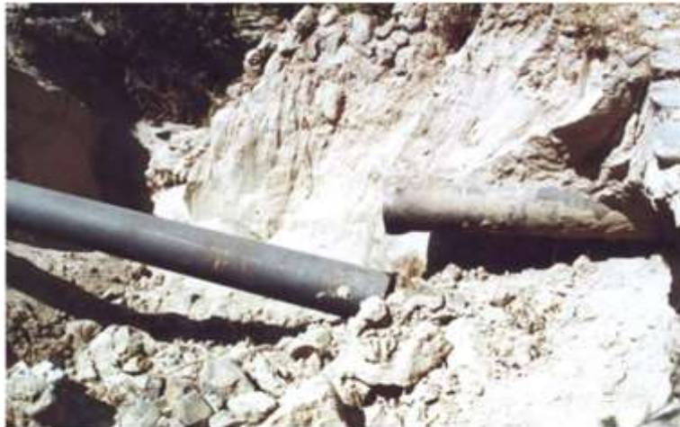
Figura 1.3 Los sismos pueden producir efectos insospechados, especialmente en aquellos componentes que son de difícil inspección visual.
