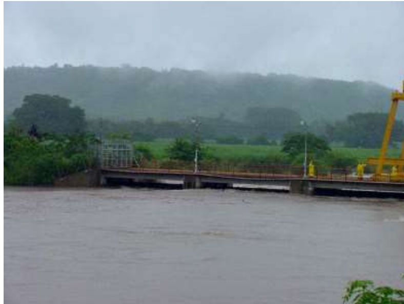
Figura 5.7 Captación del Río Lempa, Oct. 05, 2005. Durante el paso de la tormenta Stan. /fuente CEL
