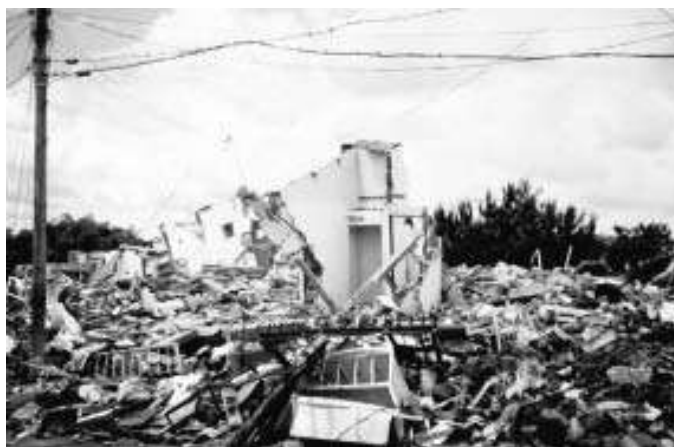
Figura 3.8 Generación de escombros después del terremoto de Armenia, Colombia, febrero 1999.
