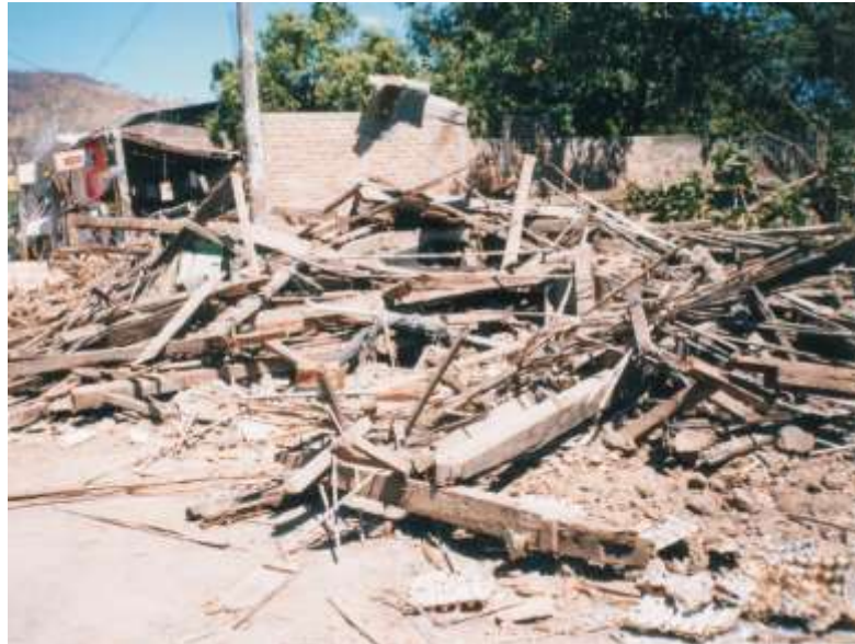
Figura 3.3 Bloqueo de vías por escombros./ COMURES, 2001
