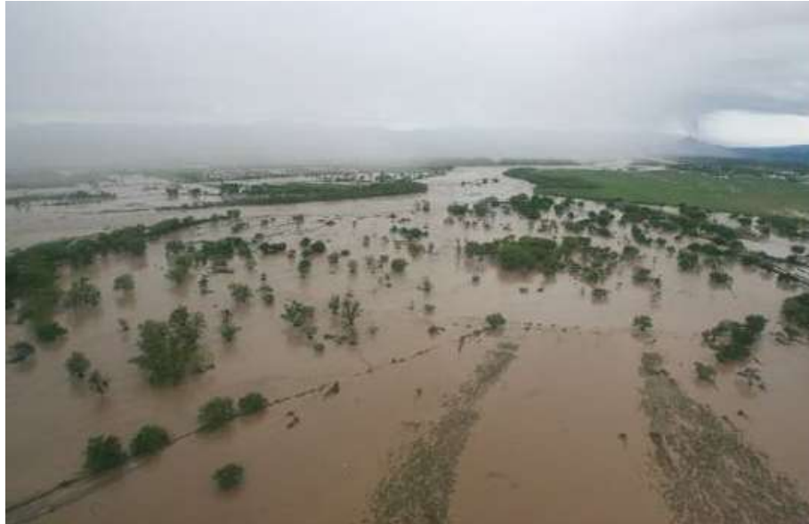
Figura 5.9 Inundaciones provocadas por el río Lempa en la zona baja/fuente MARN
