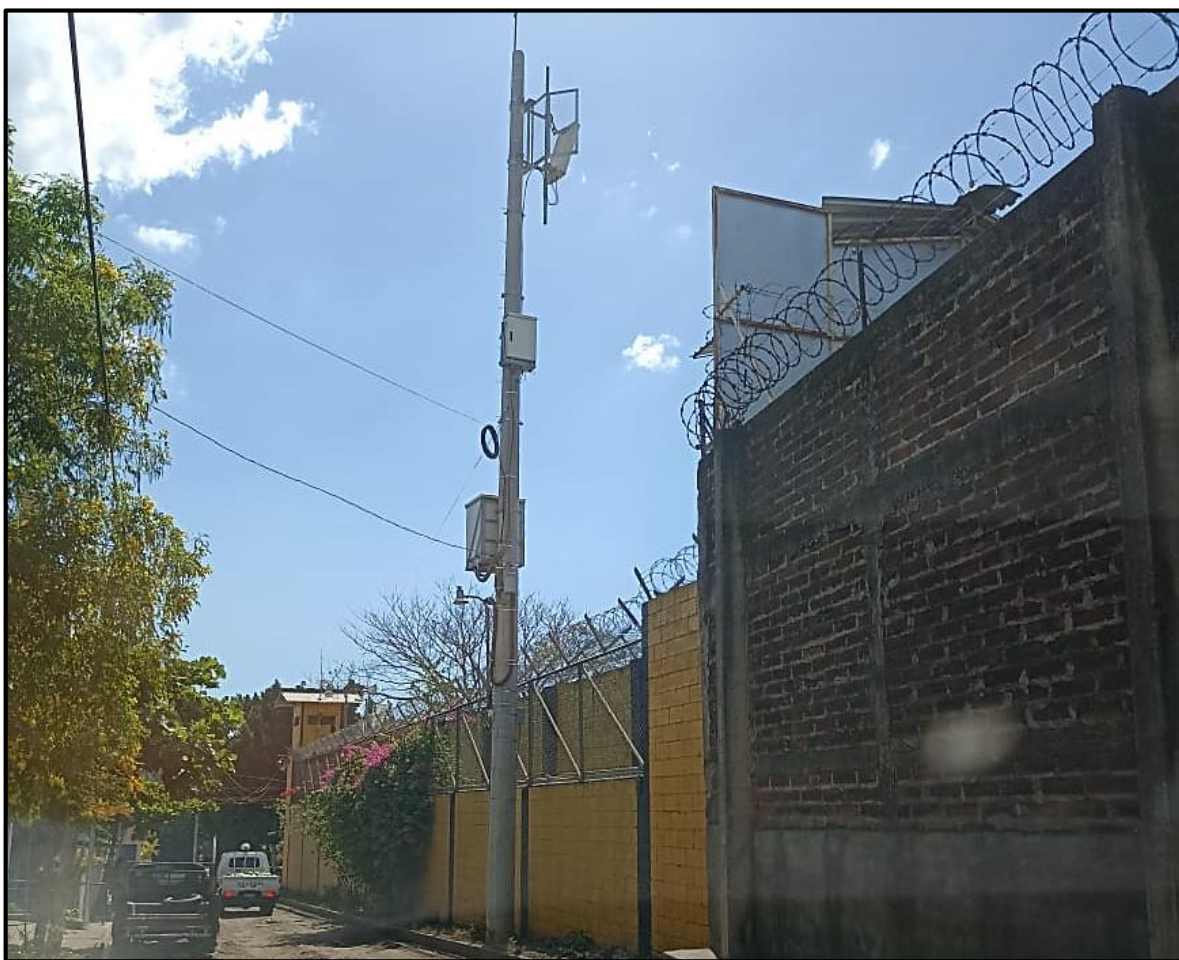
Figura 44: Sector mudo instalado afuera de un centro penitenciario. (H. Torres, 2022).
