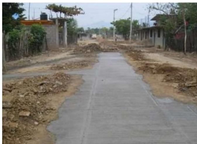
**Figura 2-17 Método de curado con tierra húmeda.**
