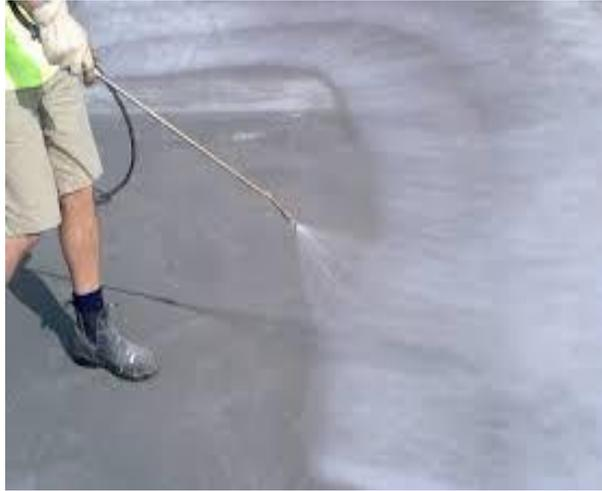
**Figura 2-18 Método de curado con producto químico.**
