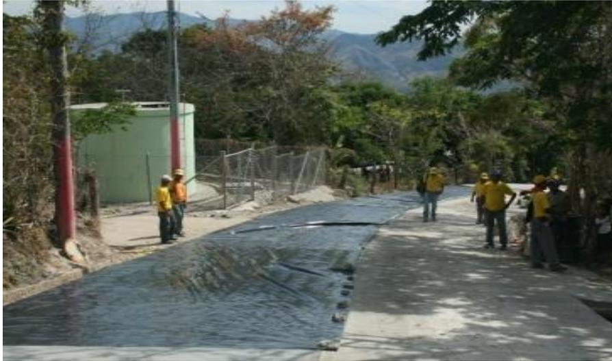
**Figura 2-19 Método de curado con películas plásticas.**
