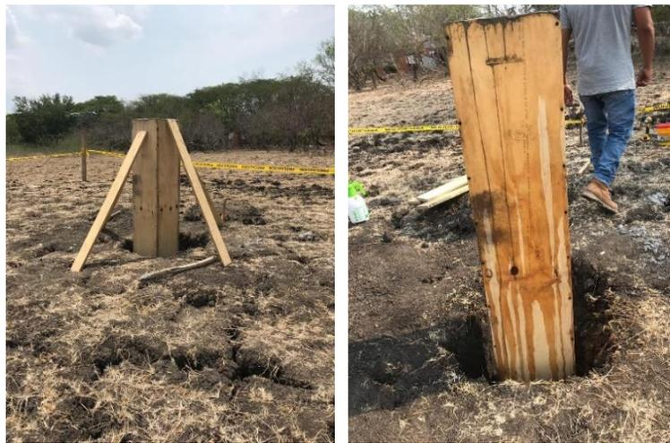
**Figura 4-37 Encofrado y terminado de columna.**
