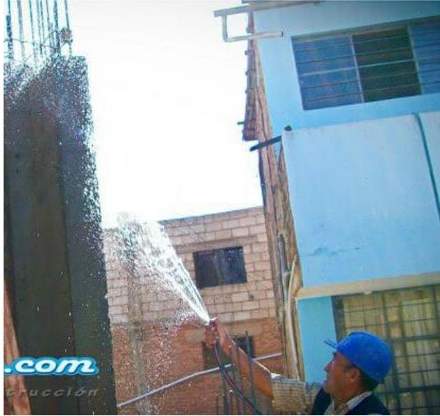
**Figura 2-15 Método de curado mediante riego o aspersión de agua.**
