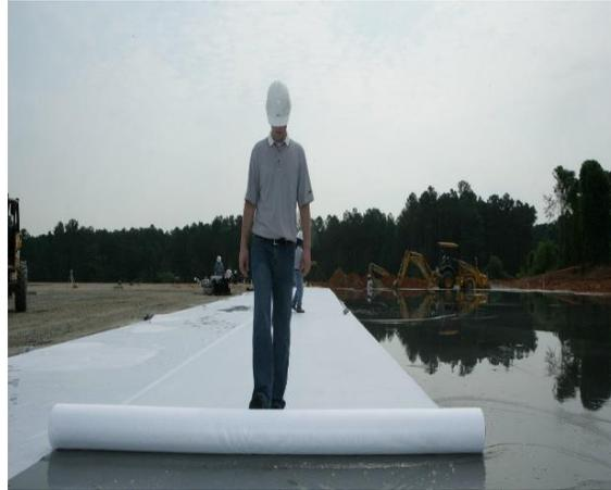
**Figura 2-20 Método de curado con papel impermeable.**
