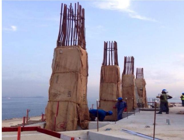
**Figura 2-16 Método de curado con sacos de yute en columnas.**
