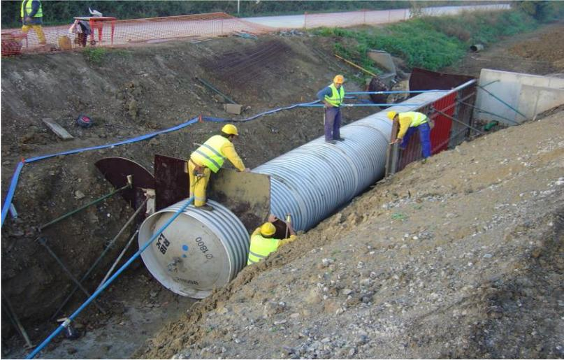
Figura 2.3.- Tubería RIBLOCK utilizada en sistemas de alcantarillado.
