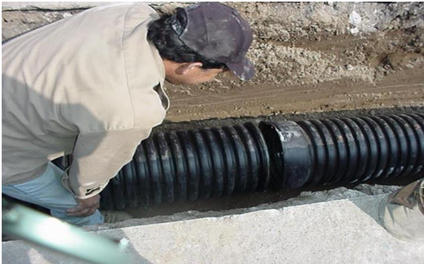
Figura 2.2.- Tubería A.D.S. utilizada en sistemas de alcantarillado.
