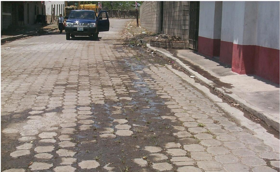
Fig.1. Deterioro de las calles por causa de las escorrentías superficiales de aguas servidas.
