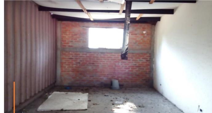
Vista interior, las paredes divisorias son de tabla yeso, ladrillo de obra rojo y metálica por los contenedores adosados. La estructura de techos es de polín C, cielo falso de tabla yeso deteriorado. Piso de arena y cemento. La ventana es de celosía de vidrio.
