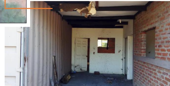
Vista interior, las paredes divisorias son de tabla yeso, ladrillo de obra rojo y metálica por los contenedores adosados. La estructura de techos es de polín C, cielo falso de tabla yeso deteriorado. Piso de arena y cemento.
