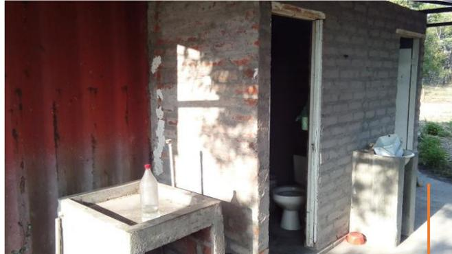
Vista de los servicios sanitarios de la construcción existente, se identifican paredes de ladrillo de obra rojo, adobe. Los inodoros que funcionan con agua potable cuya conexión descargas de aguas negras no se identifica.
