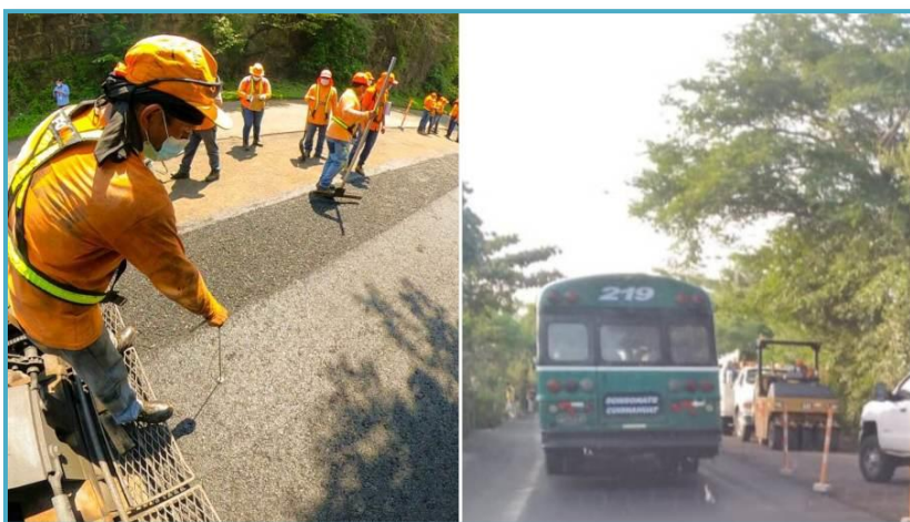
Imagen N°18: Desvío de transporte público por obras en construcción. Fuente: google imágenes.
