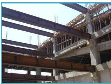
Imagen N°22: Uso y combinación de estructuras mixtas. Fuente: google imágenes.
