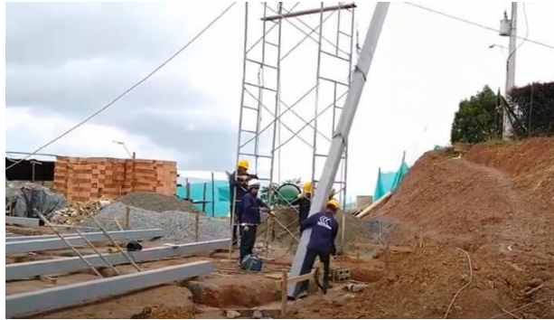
Imagen 18. Detalle de montaje de columna metálica. Fuente: Youtube: Cómo instalar una columna metálica. Estructuras Medellín Estruma S.A.S
