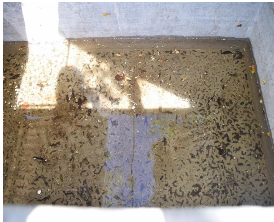
Imagen 7: Observación de las condiciones actuales de reservorio en sector Las Lajas
