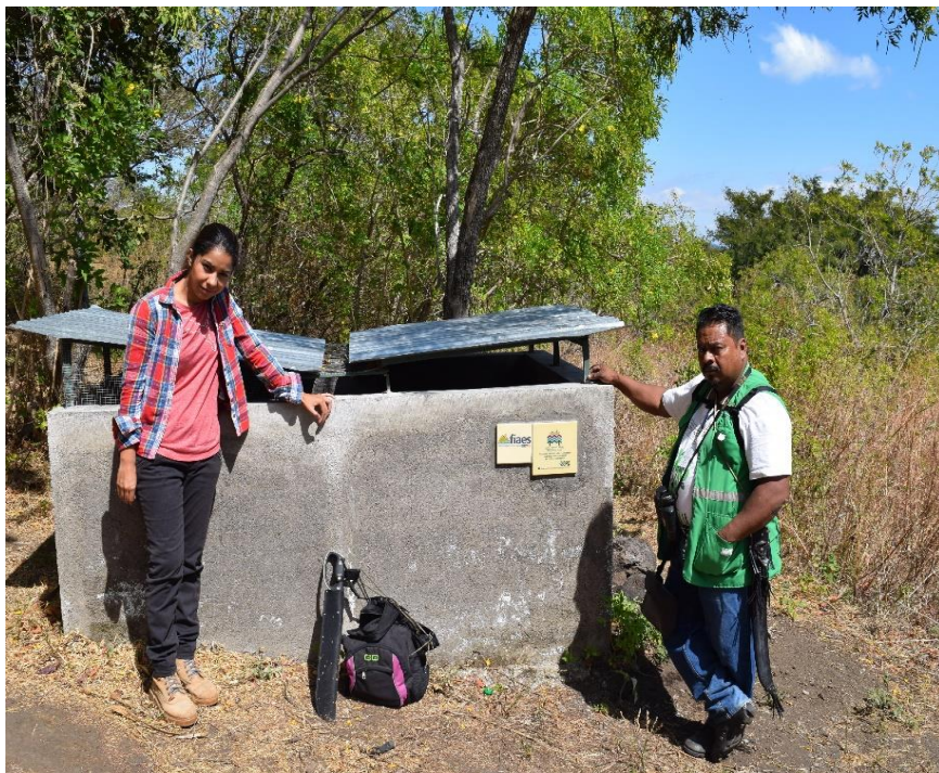
Imagen 6: Observación de las condiciones actuales de reservorio en sector Las Lajas
