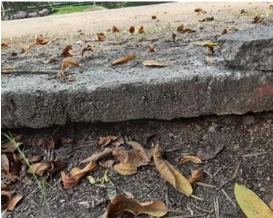
Figura 16. Pavimento de piso interior
