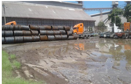
Figura 21. Almacenaje de productos en área no pavimentada
