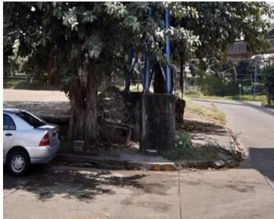
Figura 17. Muros de retención
