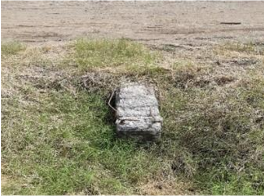
Figura 14. Fundaciones de la bodega Exicasa
