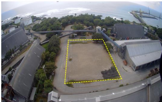
Figura 20. Área no pavimentada del Patio 6
