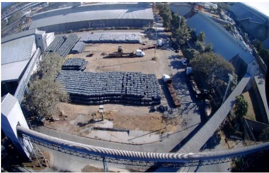
Figura 18. Saturación de suelos debido a las lluvias
