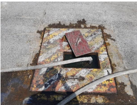
Figura 30. Ubicación de hidrante 35 metros al poniente Fuente: Elaboración propia
