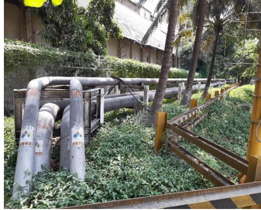
Figura 33. Rotulación para tuberías Fuente: Elaboración propia
