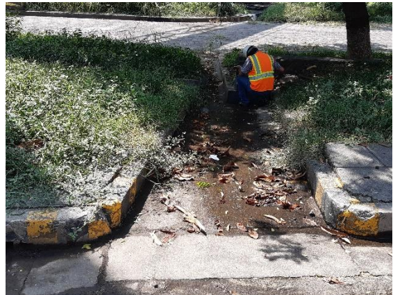
Figura 37. Badén de 1.20 metros de ancho hacia caja colectora
