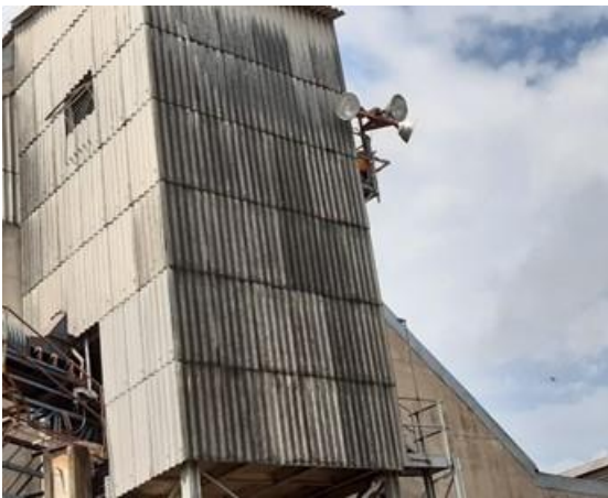
Figura 25. Elemento 5, luminaria adosada a bodega Fuente: Elaboración propia
