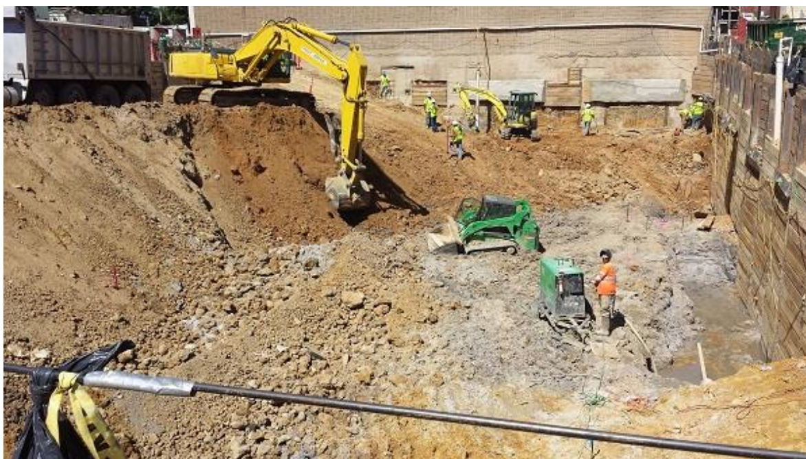
Figura 5 –Obras de terracería. Fuente: Elaboración propia.
