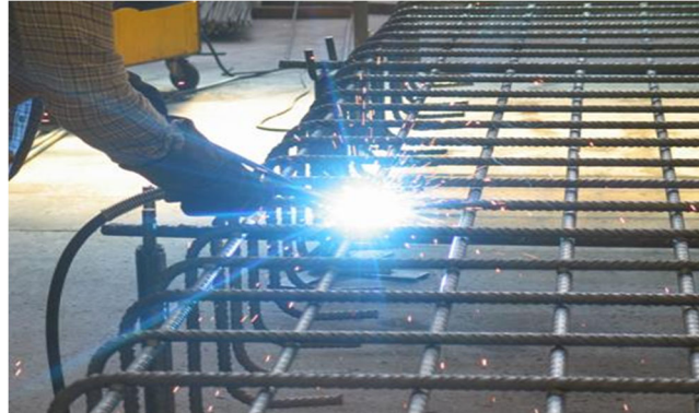
Ilustración 18: Trabajo con Armadura
