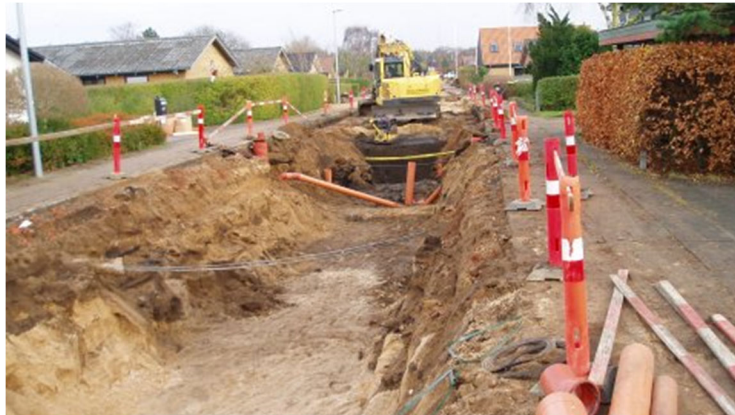
Ilustración 17: Trabajo de Excavación
