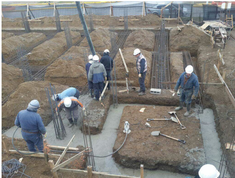
Ilustración 20: Medidas generales trabajos de Hormigonado
