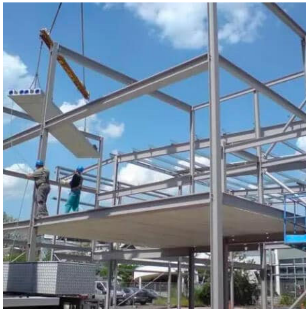
Ilustración 13: Estructura tipo Metálica
