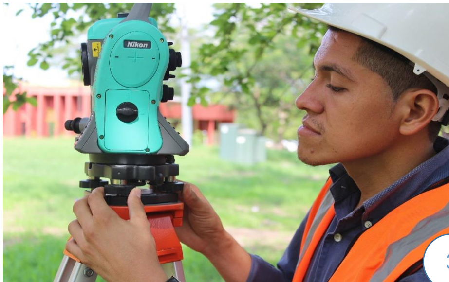
Ilustración 21 - 1. Punto de estación; 2. Colocación de trípode; 3. Nivelado y sujeción del aparato.
