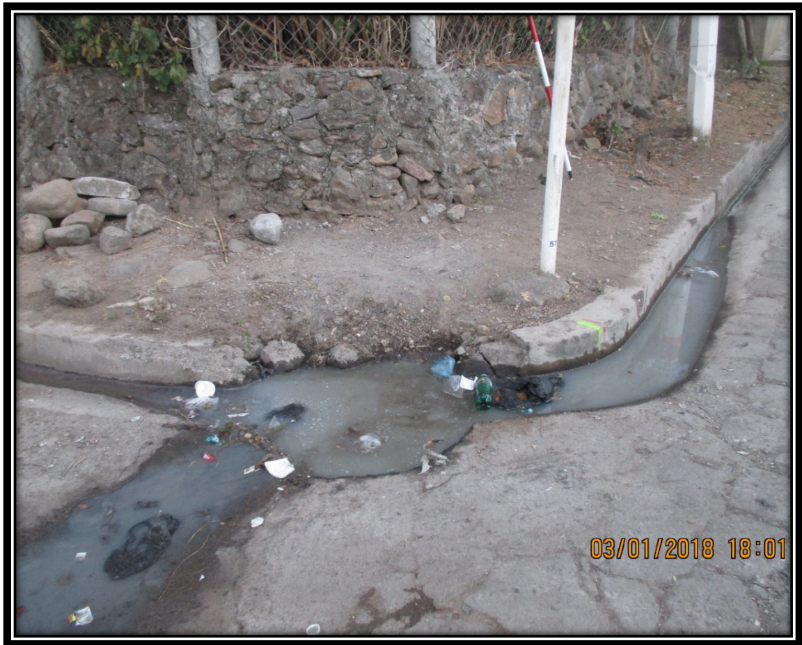
Imagen 2. Agua residual doméstica y residuos sólidos estancados en las cunetas.
