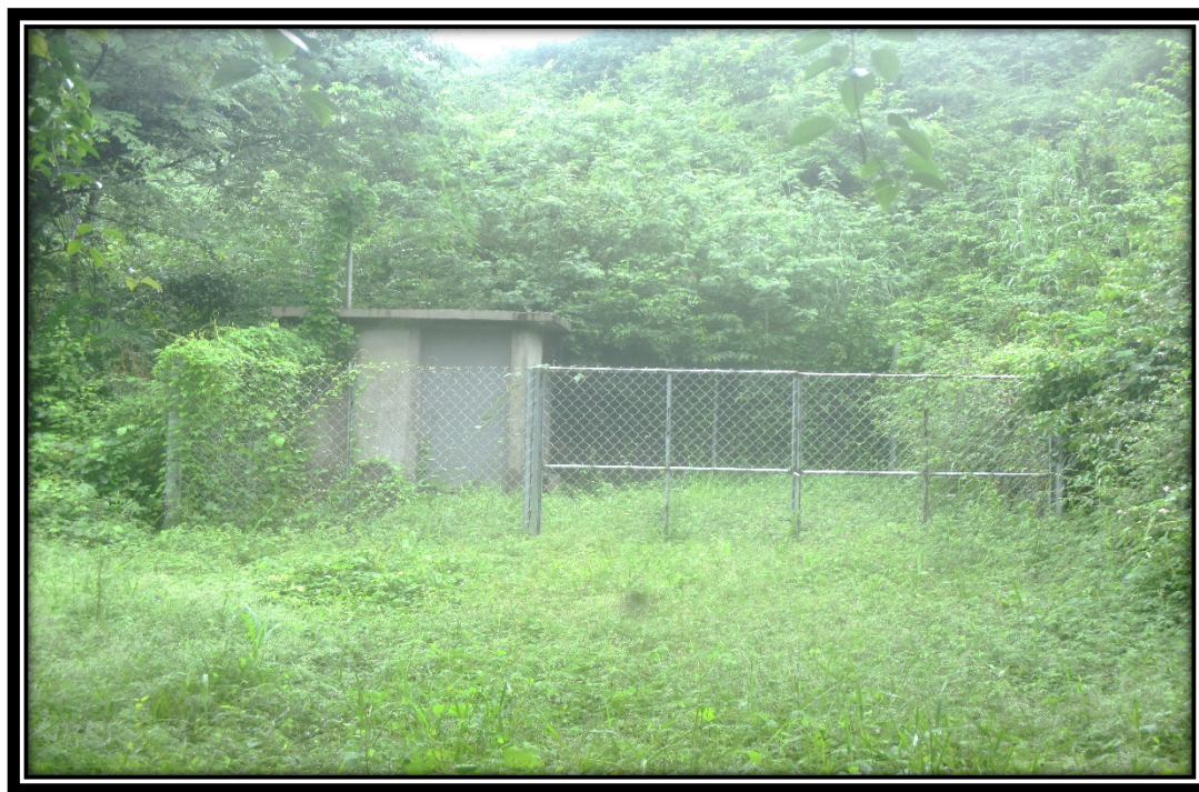
Imagen 27. Instalaciones del pozo perforado.
