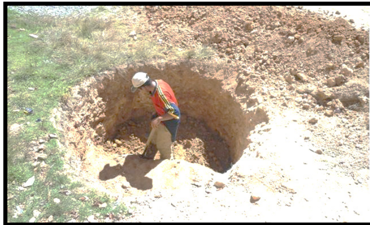
Excavación de pozo de absorción
