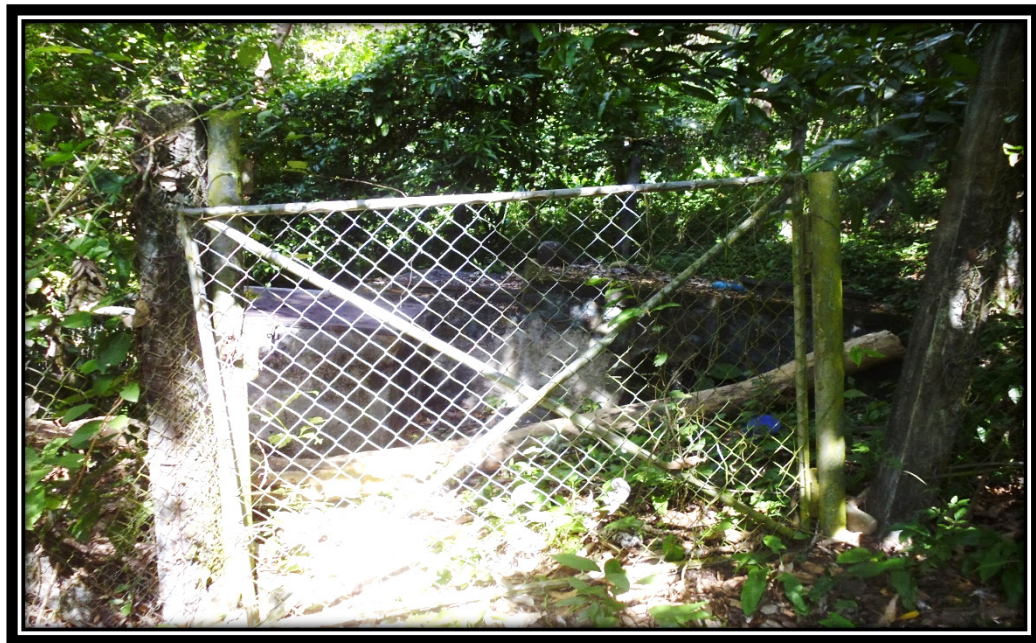
Imagen 26. Portón de acceso a la captación.
