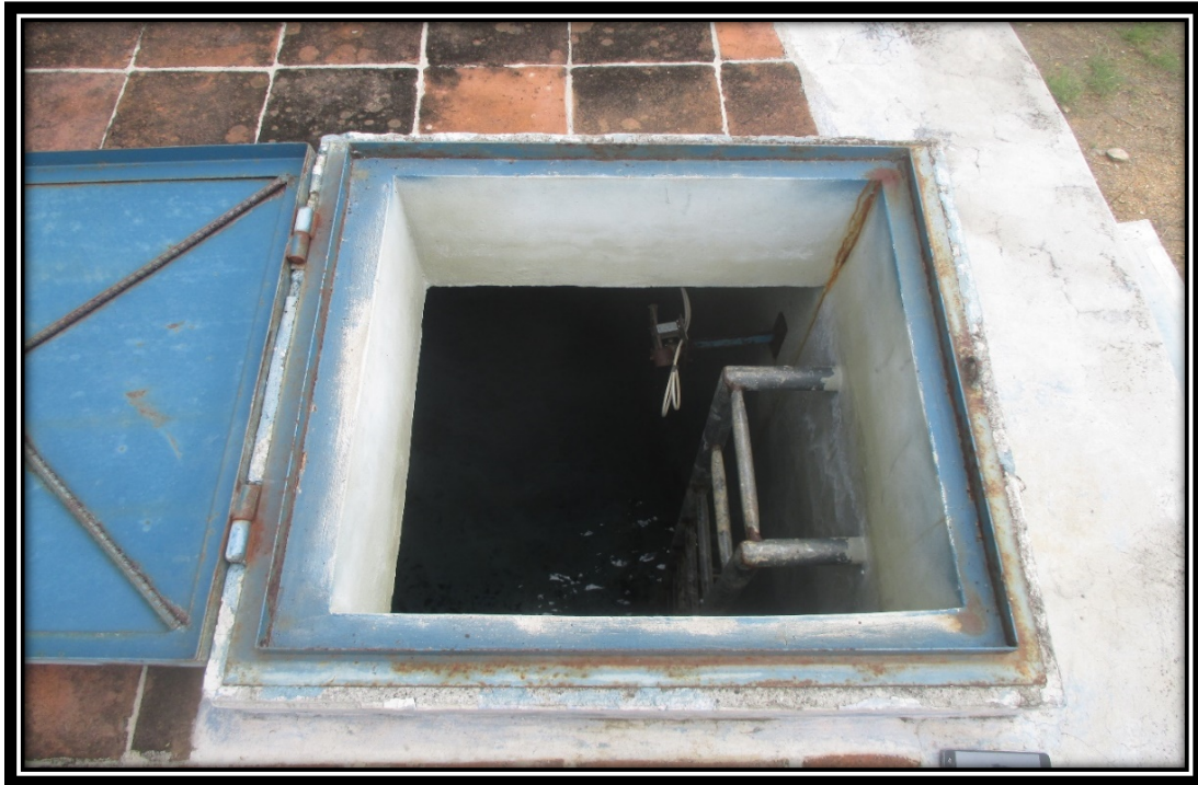
Imagen 12. Entrada hacia el interior del tanque.
