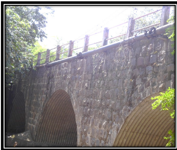
Imagen 9. Línea de Conducción (Impelencia) hacia tanque de almacenamiento.
