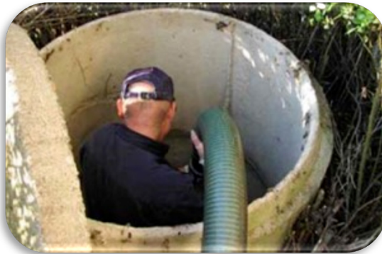
Limpieza en el pozo de absorción
