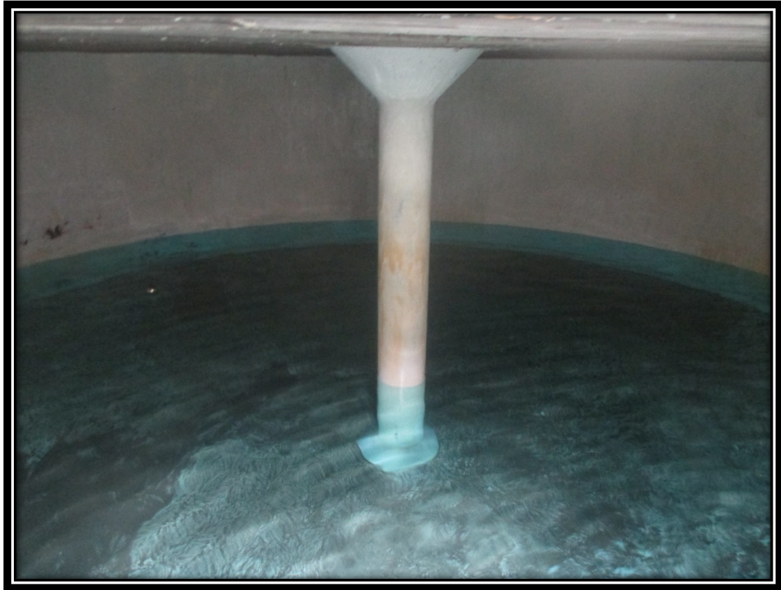
Imagen 15. Vista interna del tanque de almacenamiento.
