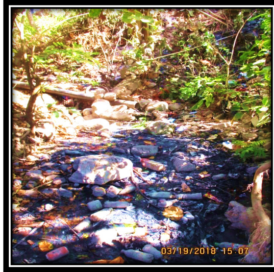
Imagen 39. Punto de vertimiento 4. Desagüe de aguas grises de tubería de PVC
