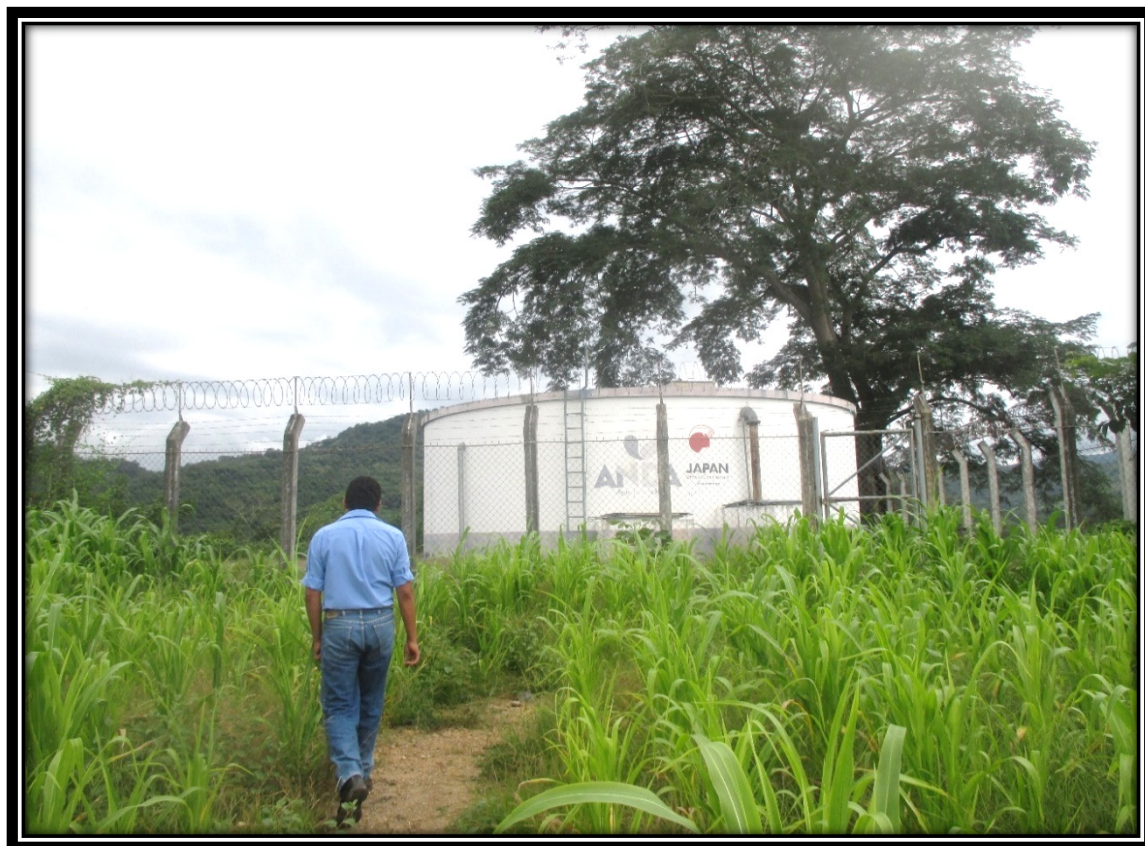
Imagen 10. Tanque de almacenamiento para los barrios en la ciudad de Sesorí.
