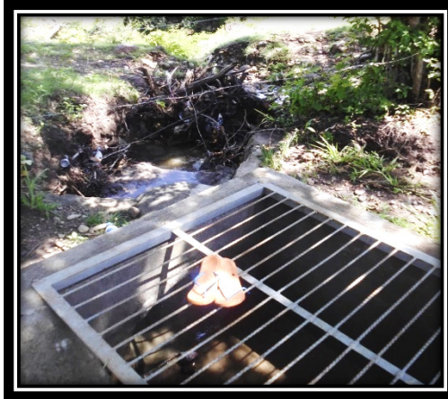
Imagen 41. Tragante 10 de aguas grises y lluvias en colonia Libertad.
