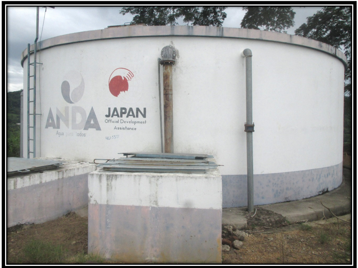
Imagen 11. Tuberías de ingreso de agua.
