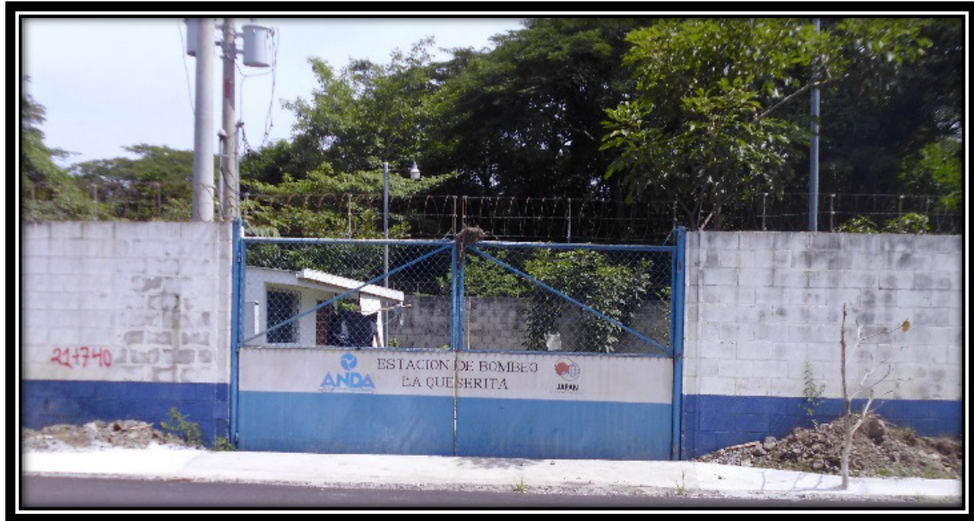
Imagen 6. Estación de bombeo Queserita.
