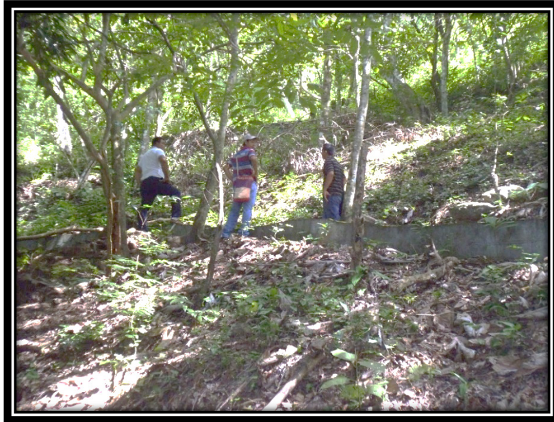
Imagen 22. Obras de protección y reforestación, en zona de captación de agua.
