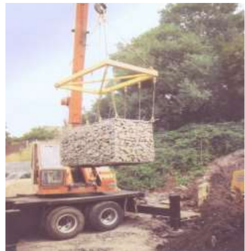
Figura Nº 5.14: Gavión caja siendo Traslado con grúa. Fuente: Maccaferri.
