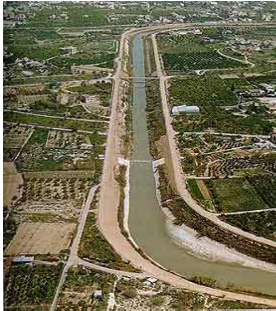
Figura Nº 5.3: Encauzamiento del río Segura a su paso por la Vega Baja.
