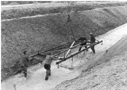
Figura N° 5.9: Colocación de colchones Reno En presencia de agua. Fuente: Maccaferri.
