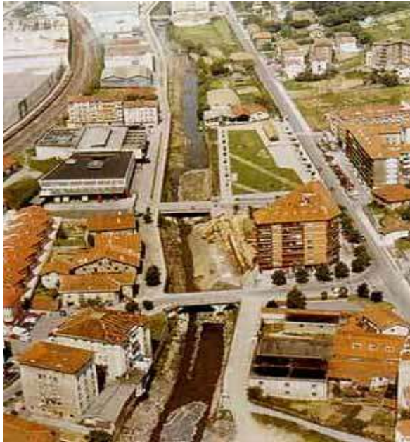
Figura Nº 5.2: Canalización del río Nervión en Llodio.
