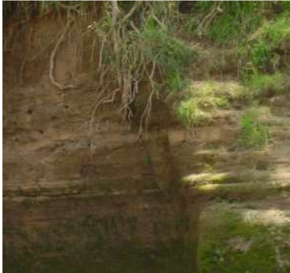
Fotografía No. 41: Muestra el Suelo que Presenta la Parte Alta del Tramo de Estudio.
