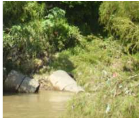
Fotografía No. 5 y 6: Muestra la orilla y Obras de Protección Caído
