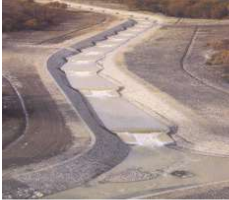
Figura N° 5.5: Canalización en colchones Reno. Fuente: Maccaferri.
