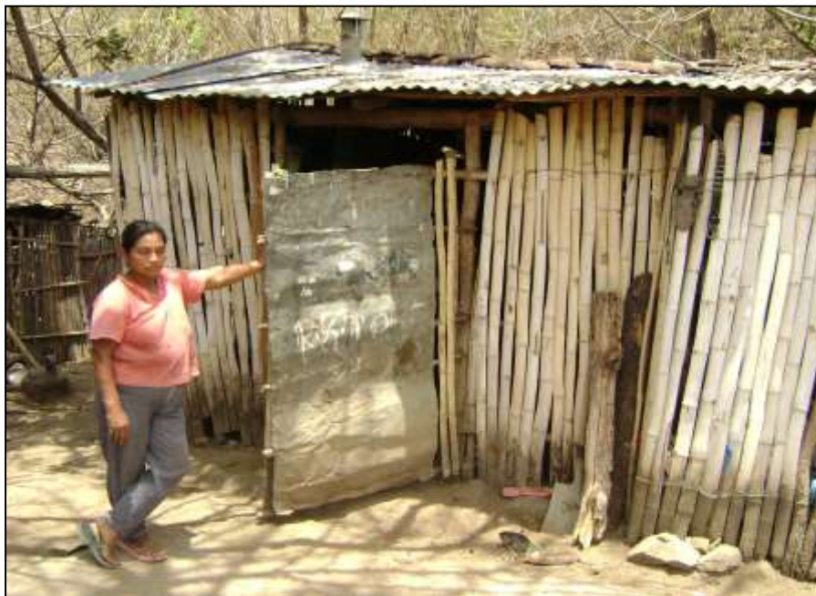
Fotografía 4.18 Vivienda con pared cuyo material es el bambú y techo de lamina, en el caserío las Anonas, cantón Tijeretas.
