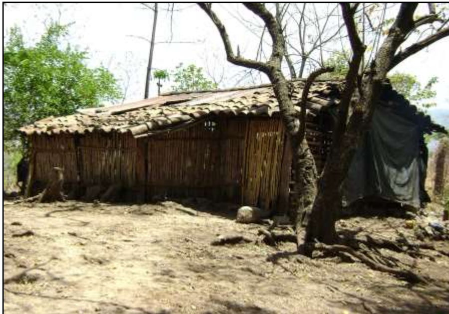
Fotografía 4.16 Vivienda de Bambú como material de pared, con techo de teja ubicada en el caserío, El Jicaro, cantón Cerrito.
