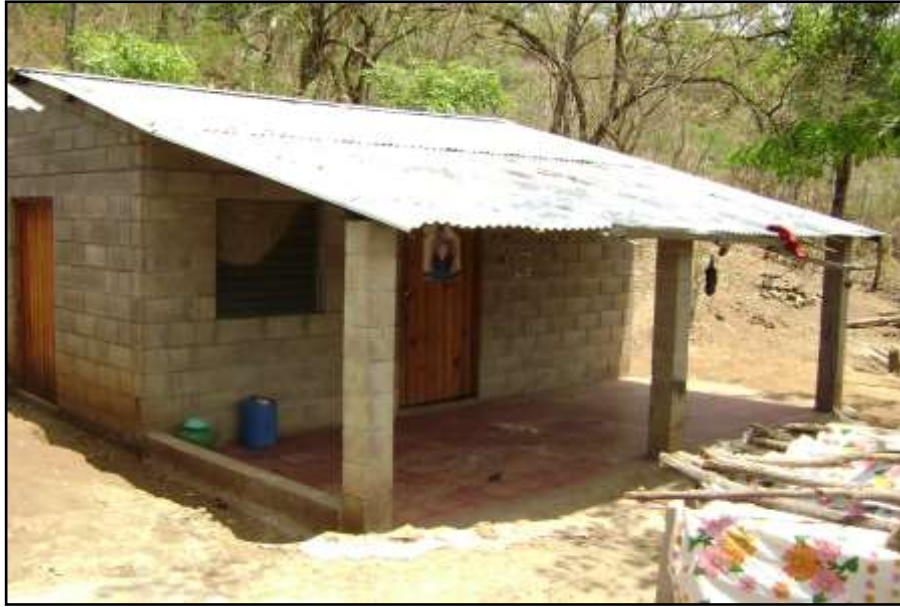
Fotografía 4.15 Vivienda de tipo de sistema mixto, con techo de lamina ubicada en el cantón El Progreso
