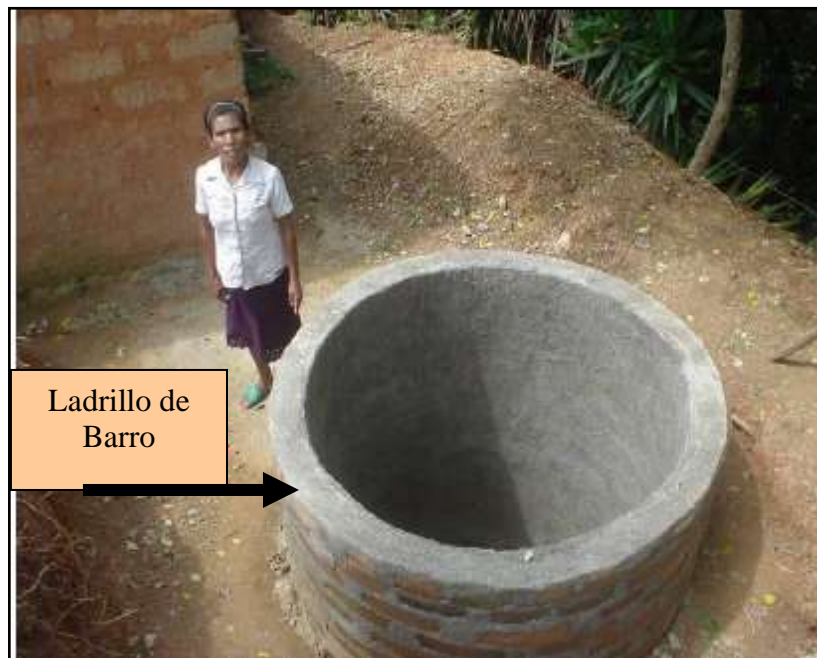
Figura 2.37 Pozo Cisterna Construido con Bloque de Arcilla Quemada
