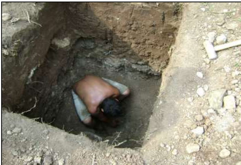
Figura 2.6 Preparación del agujero para prueba de permeabilidad
