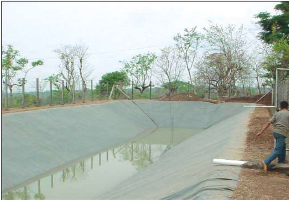
Figura 2.20: Embalse o Reservorio con Geomembrana, utilizado para riego
