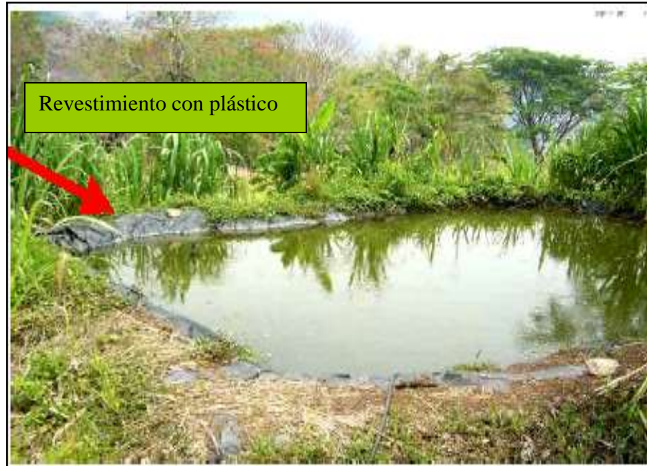
Figura 2.36. Laguneta Revestida con Polietileno para Cultivo de Peces
