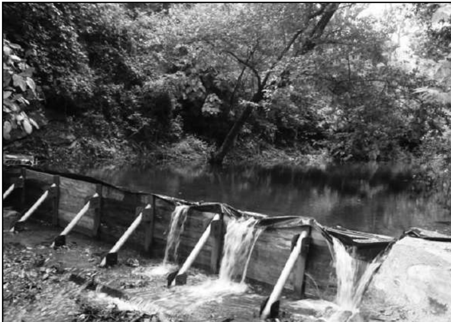
Figura 2.45. Micro Represa Desmontable de madera
