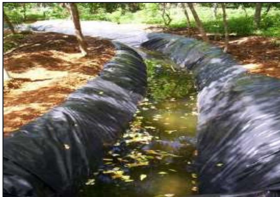
Figura 2.39 Zanja de Almacenamiento Revestido
