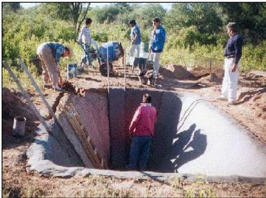
Figura 2.40 Construcción de Aljibe Revestido con Concreto
