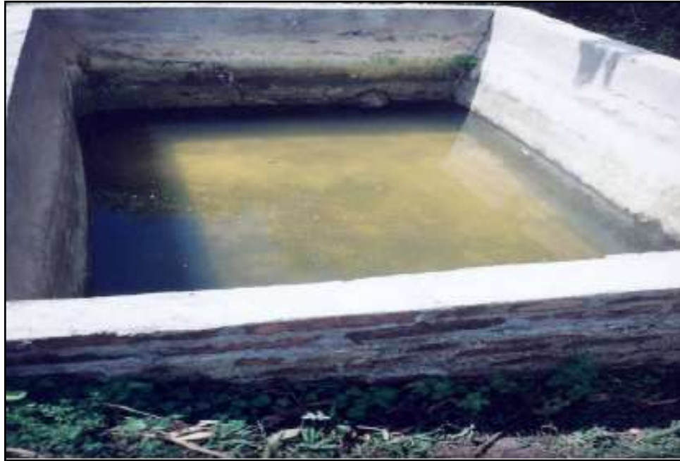
Figura 2.33. Piletas de Concreto con Bloque de Arcilla Quemado, vista interior
