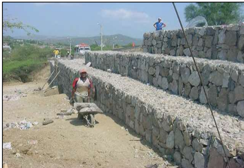
Figura 2.29 Dique con Gaviones en Quebrada
