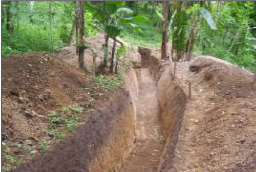
Figura 2.38: Excavación de Zanja
