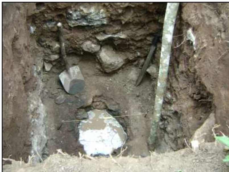
Fotografía 4.21 Agujero lleno de agua a una altura de 30 cm
