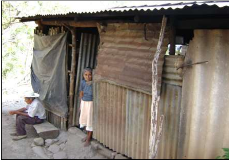
Fotografía 4.17 Vivienda con Lamina como material de pared y Techo, piso de Tierra ubicada en el cantón El Progreso
