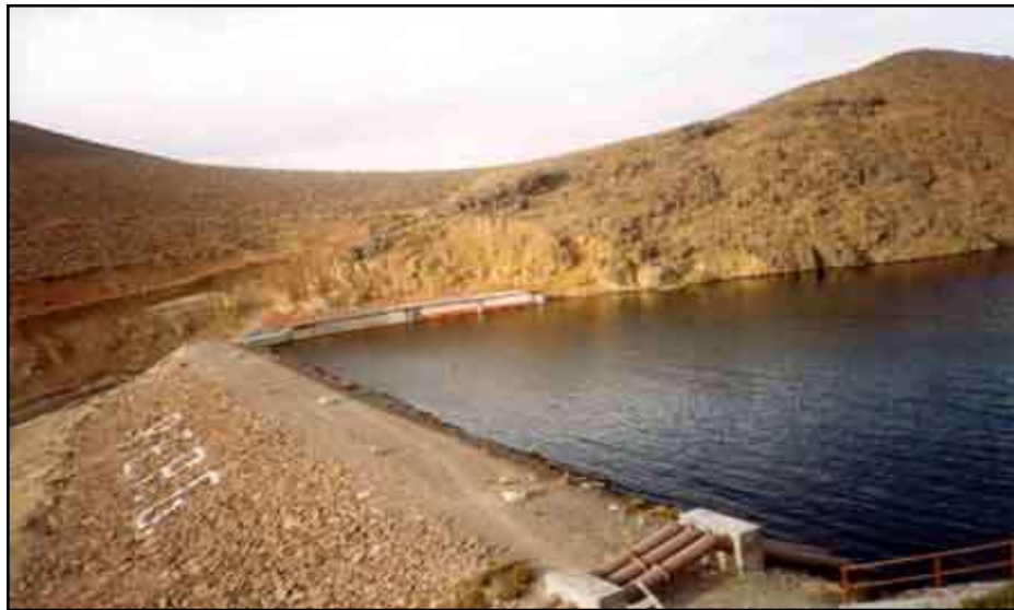
Figura 2.25 Presa De Tierra
