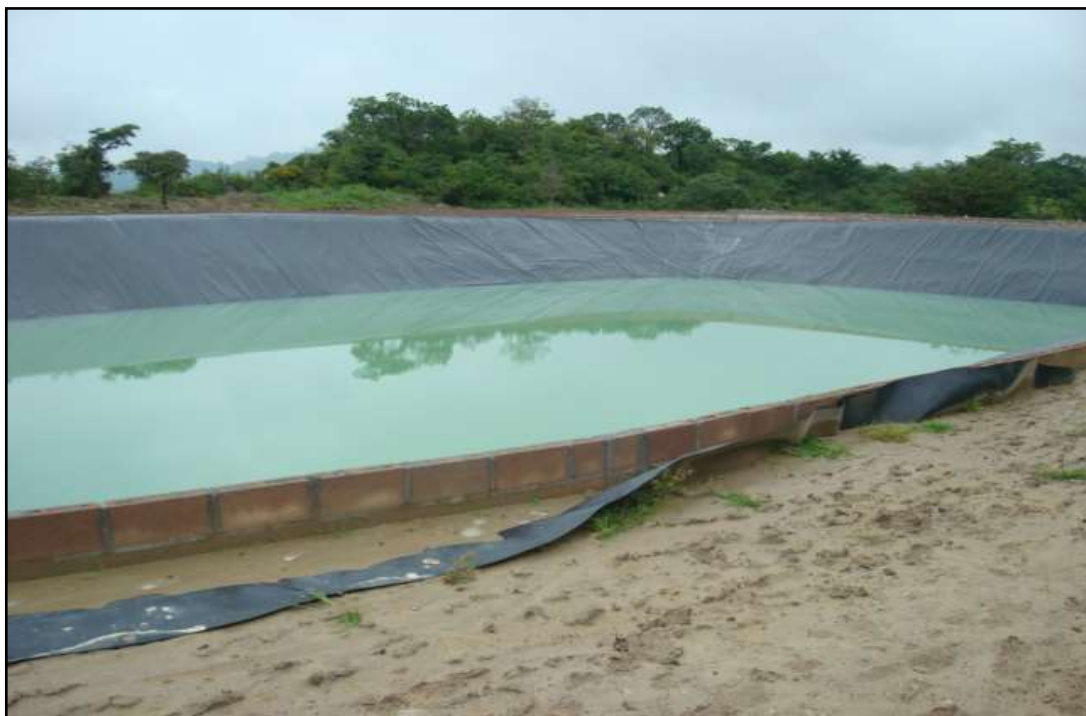
Figura 2.1 Reservorio ubicado en el municipio de Meanguera, Morazán con una capacidad de almacenamiento de 17000 m 3 , para abastecer de agua potable a 927 familias.
