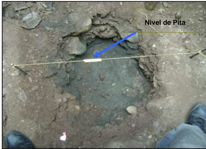
Fotografía 4.20 imagen donde muestra la pita totalmente horizontal
