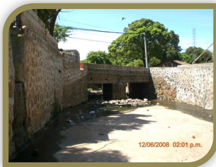
Fotografía 4.5.3 Tramo 1 sección a analizar que consta de dos bóvedas, en este sector se ha pavimentado un tramo antes de llegar al puente como se puede observar.
