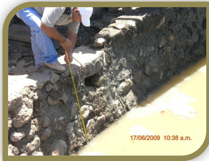
Fotografía 3.2.1.4 Altura de la marea en condiciones normales en la parte baja de la quebrada, se observa que la altura de agua es de 1.75 mt. llega pocos centímetros al límite de las bordas.
