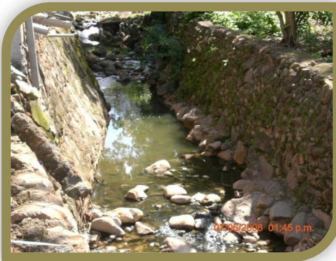
Fotografía 3.2.1.8 Reducción de cauce de la quebrada por viviendas construidas en las orillas y esta con poca vegetación y en algunos casos nula.
