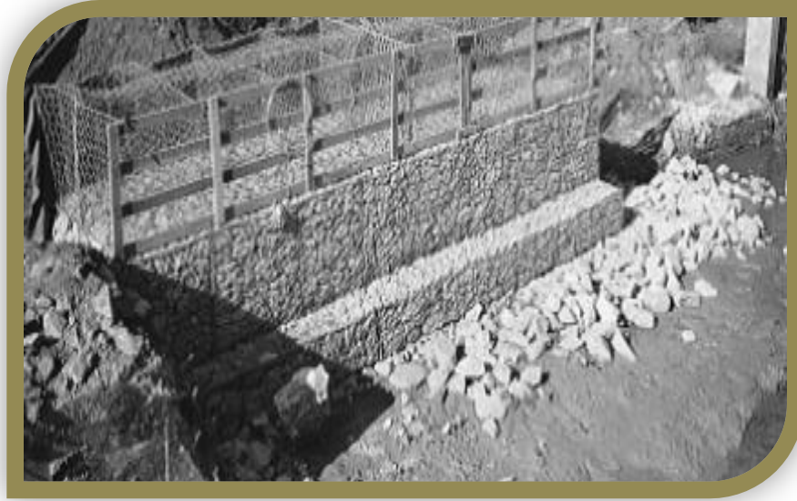
Figura 2.3.12.3.1 Detalle constructivo de obra con gaviones caja
