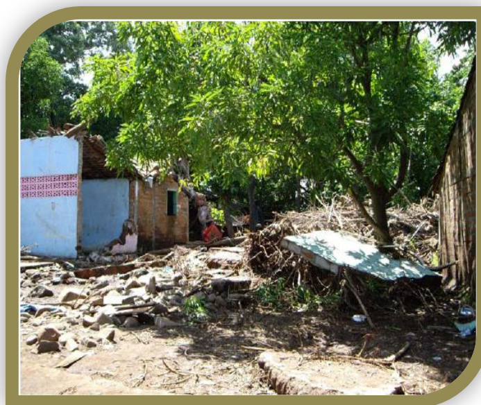
Fotografía 3.5.3 Casa arrastrada por la escorrentía, se observa ramas y algunos bloques de las paredes destruidas, también el techo de algunas casas.
