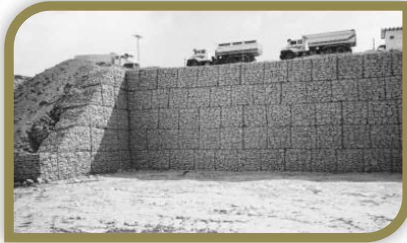
Figura 2.3.1 2.2.2 Contención para acceso a chancadora
