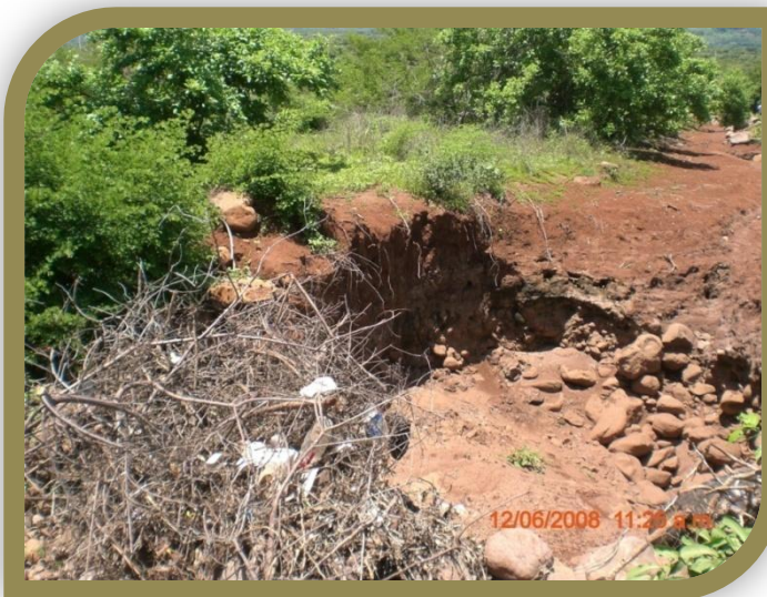
Fotografía 3.2.1.11 Matorrales en la zona y socavación debido a la erosión en el cauce principal de la quebrada.
