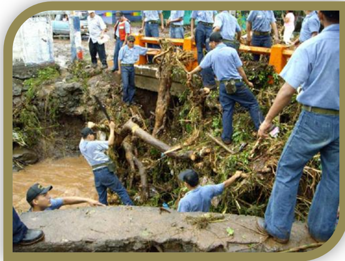
Fotografía 5.1.2.5 Sedimentos, ramas y árboles arrastrados por la escorrentía durante uno de los eventos extremos que analizaremos en nuestro estudio para mitigar los desbordamientos, este evento fue el huracán DEAN.
