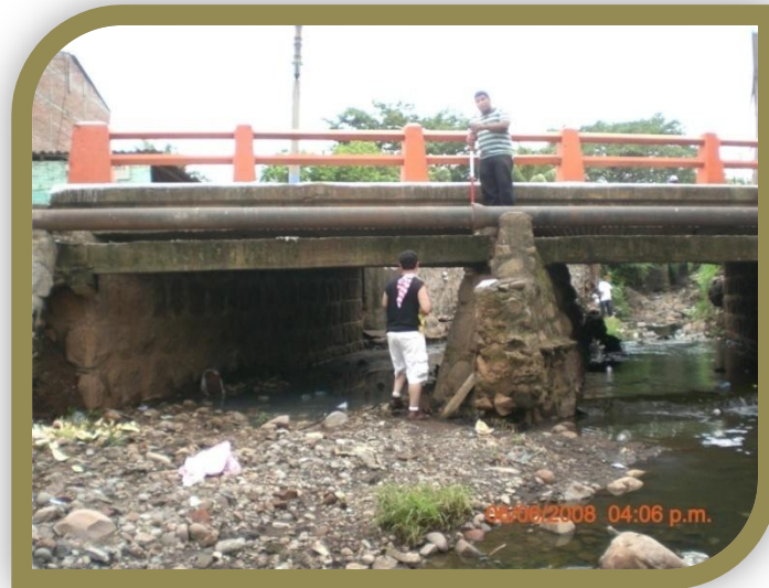
Fotografía 4.5.4 Tramo 2 Puente de la carretera hacia San Miguel sobre la 3ª calle poniente, el cual es nuestro segundo punto de interés.
