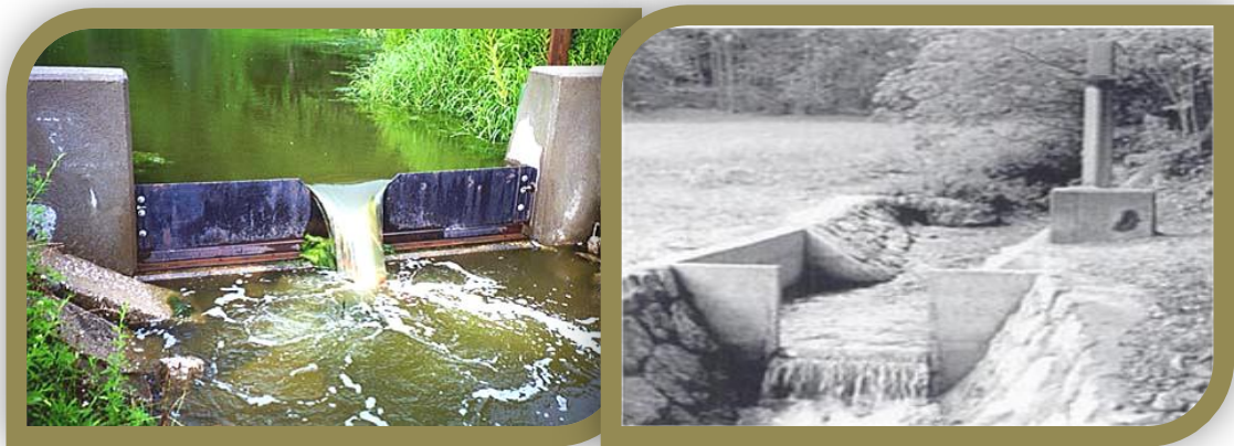
Fotografía 2.3.5.2.5 Vertederos triangular y rectangular de pared delgada.
