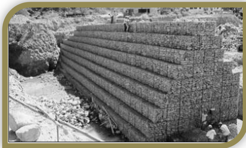
Figura 2.3.1 2.2.1 Sección robusta donde se observa la monoliticidad del conjunto
