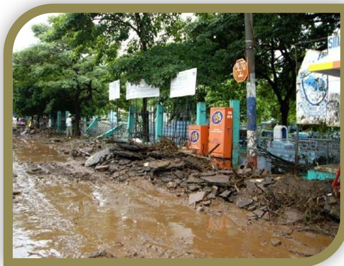
Fotografía 3.5.2 Lodo en la carretera hacia San Miguel sobre la 3ª calle poniente, se observa partes de asfalto arrancado de la calle y el muro del cementerio en una parte destruido y sedimentos en la calle.
